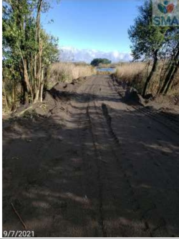
Foto N° 12 relleno para nuevo acceso laguna sobre humedal urbano (bajada 4), foto da cuenta de movimiento reciente de maquinaria y camión.
