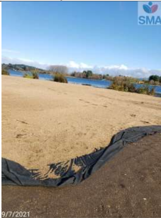
Foto N° 7 Relleno humedal urbano sector norte para habilitación de playa artificial (bajada 1) con arenas externas (café) y geotextil inferior.
