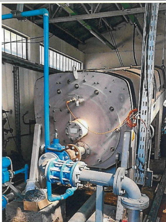
Foto 14 Estación N° 11 Centrifuga de lodos
