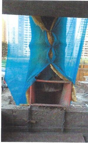
**I) Instalación de sistema de aislación acústica por ducto Shaft Torre B. Complemento lana mineral y malla raschel.**
