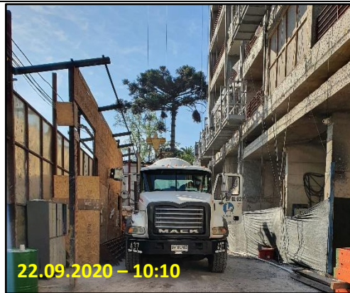
Figura 4. Túnel Acústico Camión Mixer, “Edificio Irarrázaval”.
