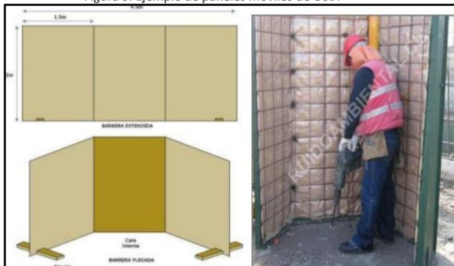
Figura 9. Ejemplo de paneles móviles de OSB.
