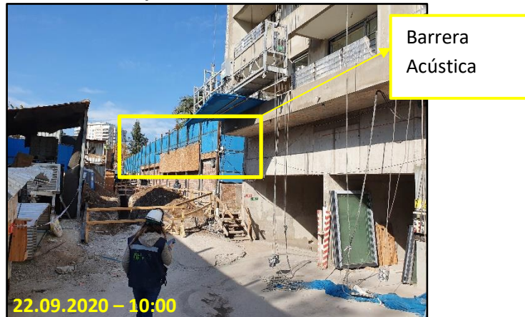
Figura 3. Cierre Perimetral y materialidad acústica, “Edificio Irarrázaval”.
