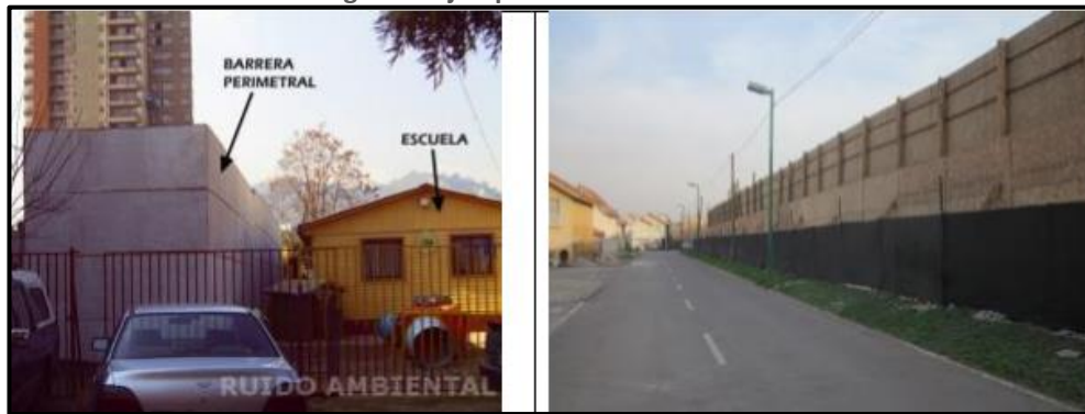
Figura 8. Ejemplo de Barreras Acústicas
