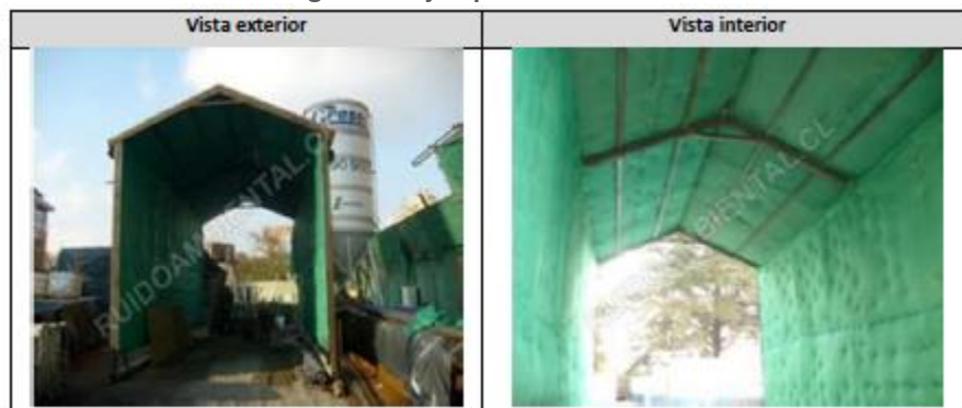
Figura 11. Ejemplo de túnel acústico.
