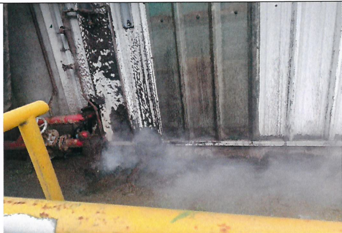
Fotografía N°15. Fuga de válvula de calentamiento.
