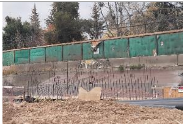
Fotografía 28 Ventana escalera emergencia ubicado entre El Dante-Gioconda, terminada medida de cierre acústico. Tapa de OSB (julio 21).
