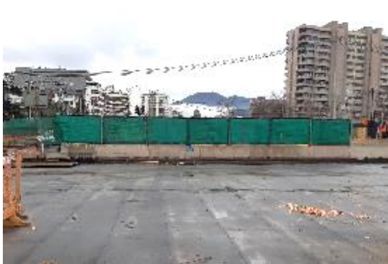
Fotografía 7 Cara interior de la obra. Postura de losa.
