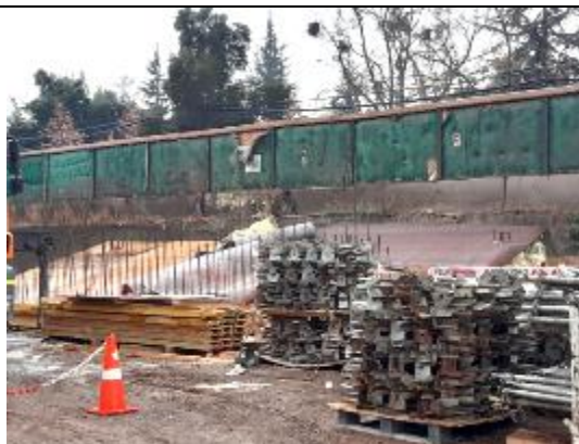
Fotografía 27 Colocación de recubrimiento exterior de panel.
