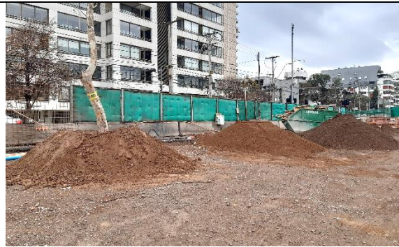
Fotografía 6 Cara interior de la obra. Trasplante de árboles.
