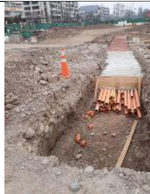
Fotografía 14 Poliducto en proceso de ejecución.
