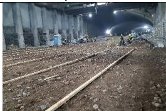
Fotografía 4 Preparación de Losas nivel -1.
