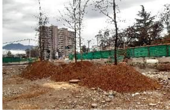
Fotografía 8 Cara interior de la obra. Trasplante de árboles.
