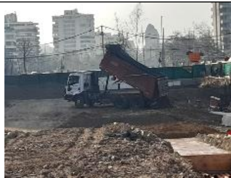
Fotografía 16 Camión tolva en proceso de descarga de tierra para relleno
