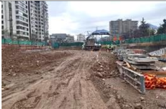
Fotografía 9 Vista general interior de la obra, camión pluma realizando movimiento de insumos.
