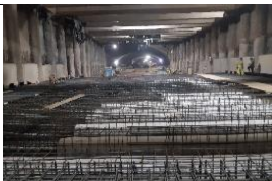
Fotografía 3 Preparación de Losas nivel -1, enfierradura.
