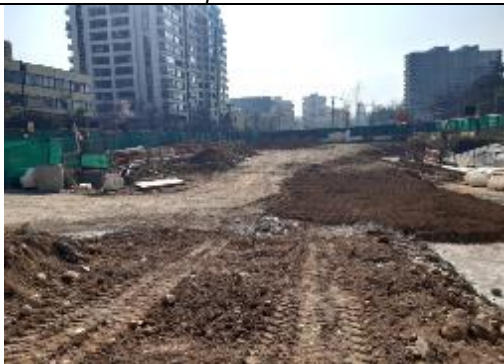
Fotografía 15 Relleno con tierra sobre poliducto ejecutado.
