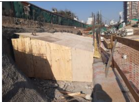
Fotografía 26 Ventana en proceso de cierre.
