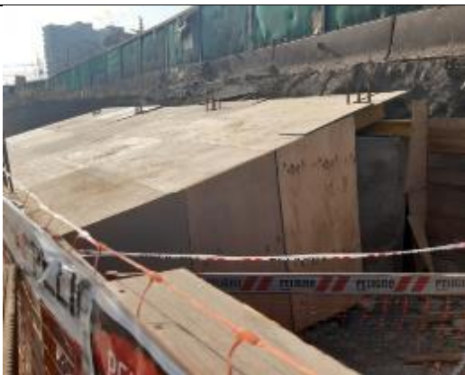
Fotografía 25 Ventana escalera emergencia ubicado entre El Dante-Gioconda, en proceso de cierre (29.06.21). Medida de control acústico.
