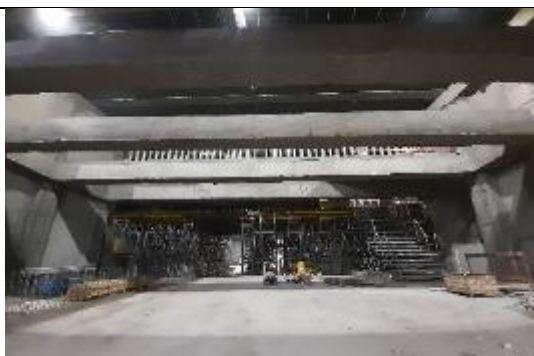
Fotografía 1 Túnel trinchera nivel -1
