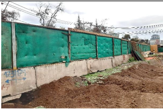
Fotografía 5 Cara interior de la obra. Trabajos de movimiento de tierra para paisajismo.
