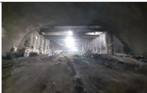
Fotografía 2 Avance Túnel nivel -1, junta túnel híbrido y trinchera cubierta.
