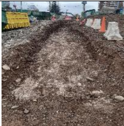
Fotografía 13 Zanja ejecutada para realizar poliducto
