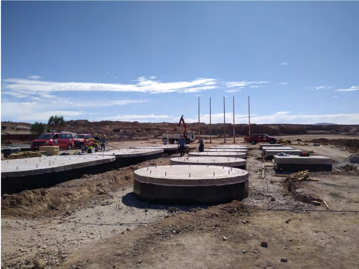
Imagen 1. Vista de fundaciones construidas
