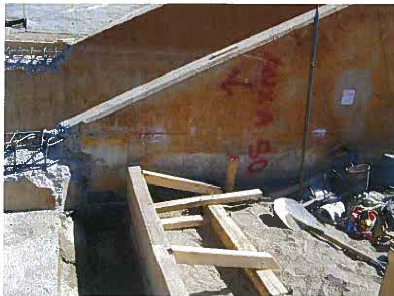
Foto 3: Reposición de Losa de Defensa.
