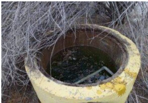
Imagen 2. Cámara de inspección piscina de emergencia (Fuente denuncia ID 15697)
