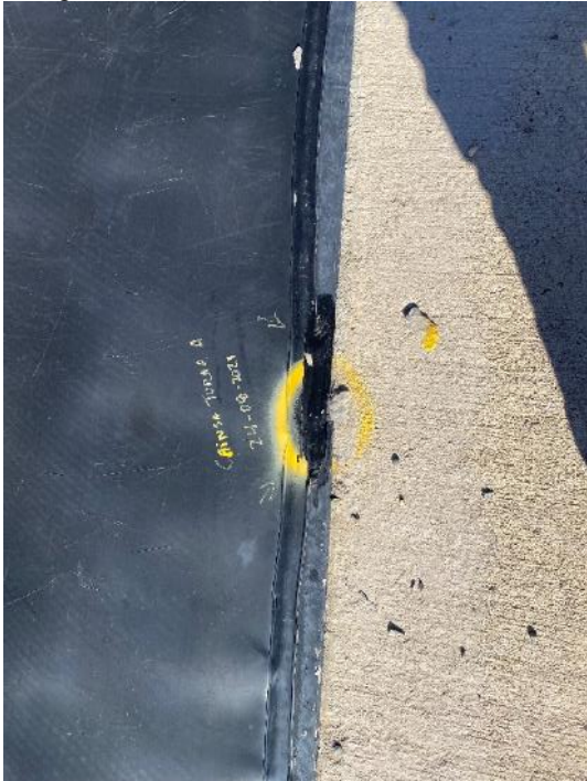
Fotografías 15 y 16: reparación de unión al inserto polimérico en rampa de acceso
