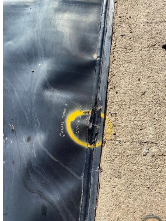
Fotografías 23 y 24: reparación de unión al inserto polimérico en rampa de acceso
