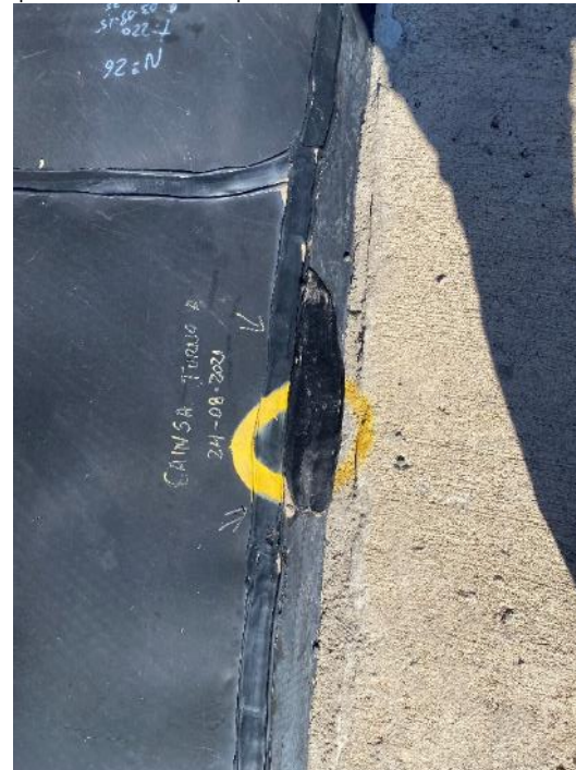
Fotografías 17 y 18: reparación de unión al inserto polimérico en rampa de acceso
