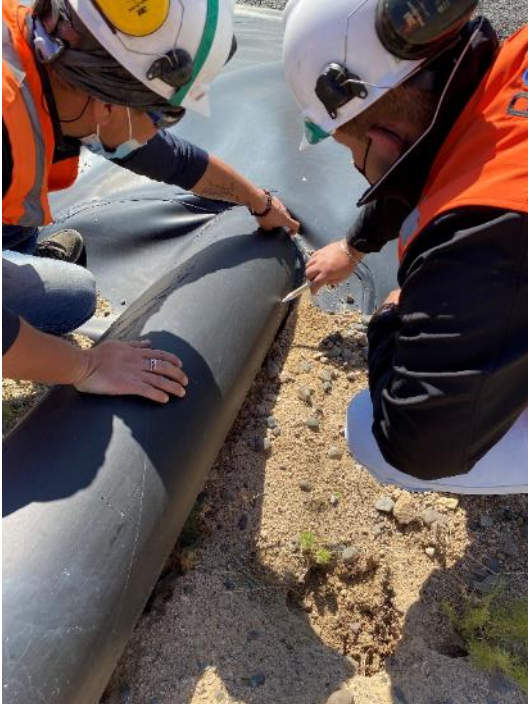
Fotografías 27 y 28: rotura de poncho en tubería de revisión de fugas en coronamiento
