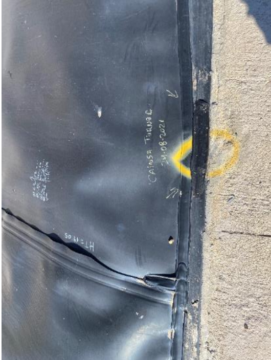
Fotografías 9 y 10: reparación de unión al inserto polimérico en rampa de acceso
