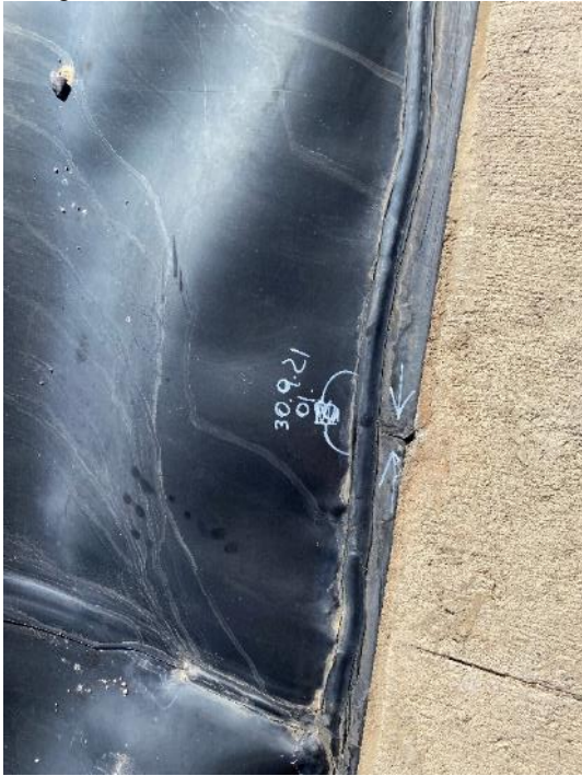
Fotografías 26: unión de inserto lijado sin soldar.
