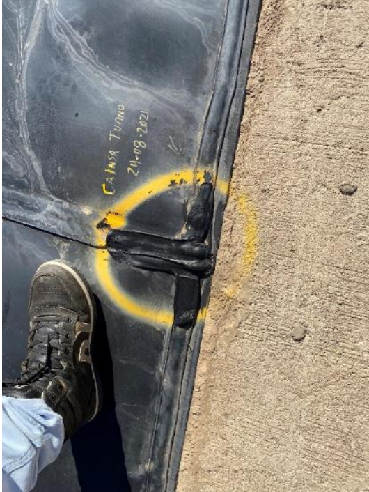
Fotografías 23 y 24: reparación de unión al inserto polimérico en rampa de acceso
