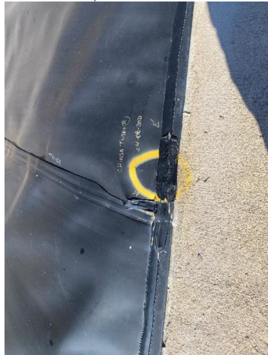
Fotografías 5 y 6: reparación de unión al inserto polimérico en rampa de acceso
