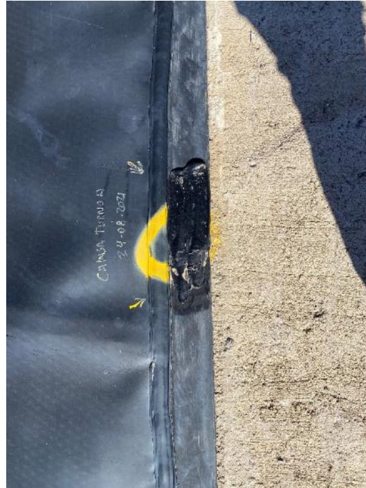
Fotografías 19 y 20: reparación de unión al inserto polimérico en rampa de acceso
