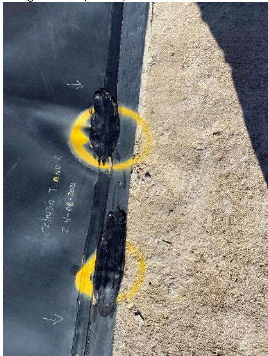
Fotografías 21 y 22: reparación de unión al inserto polimérico en rampa de acceso
