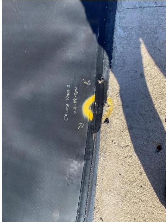
Fotografías 15 y 16: reparación de unión al inserto polimérico en rampa de acceso
