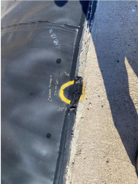
Fotografías 11 y 12: reparación de unión al inserto polimérico en rampa de acceso
