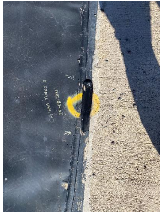
Fotografías 13 y 14: reparación de unión al inserto polimérico en rampa de acceso
