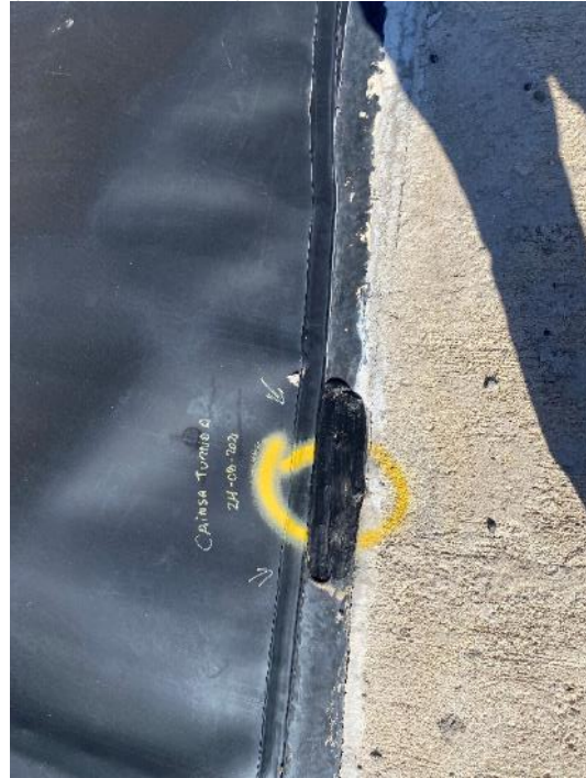
Fotografías 11 y 12: reparación de unión al inserto polimérico en rampa de acceso
