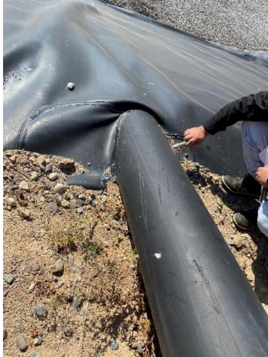
Fotografías 27 y 28: rotura de poncho en tubería de revisión de fugas en coronamiento
