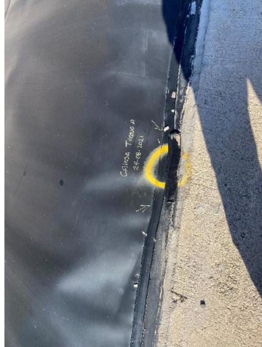
Fotografías 7 y 8: reparación de unión al inserto polimérico en rampa de acceso
