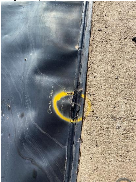
Fotografías 5 y 6: reparación de unión al inserto polimérico en rampa de acceso
