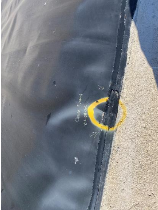
Fotografías 7 y 8: reparación de unión al inserto polimérico en rampa de acceso
