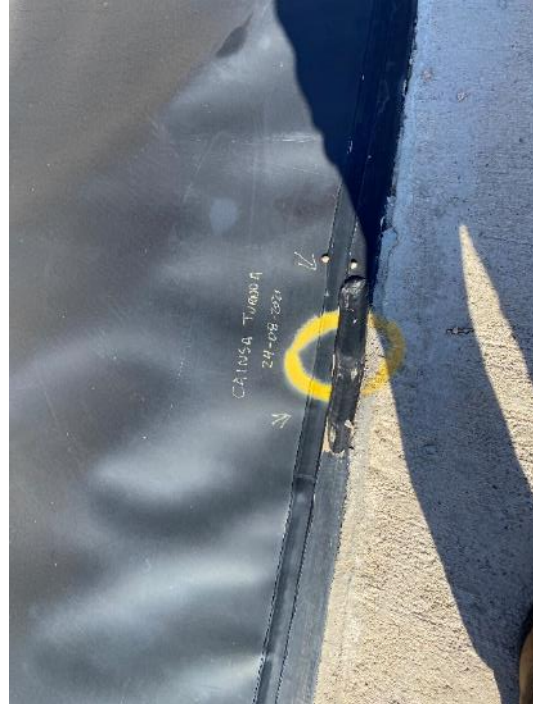
Fotografías 9 y 10: reparación de unión al inserto polimérico en rampa de acceso
