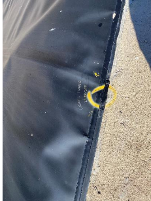
Fotografías 5 y 6: reparación de unión al inserto polimérico en rampa de acceso
