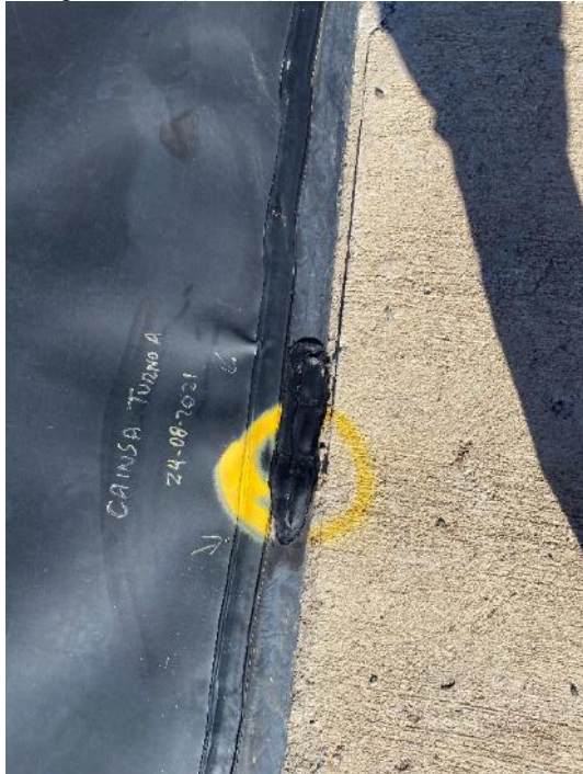
Fotografías 19 y 20: reparación de unión al inserto polimérico en rampa de acceso
