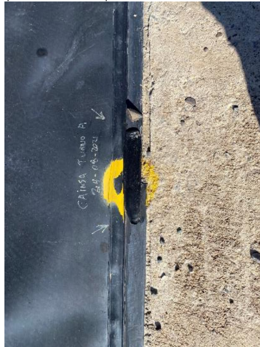
Fotografías 21 y 22: reparación de unión al inserto polimérico en rampa de acceso
