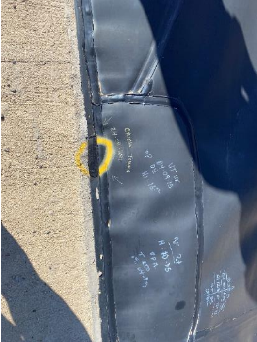
Fotografías 5 y 6: reparación de unión al inserto polimérico en rampa de acceso
