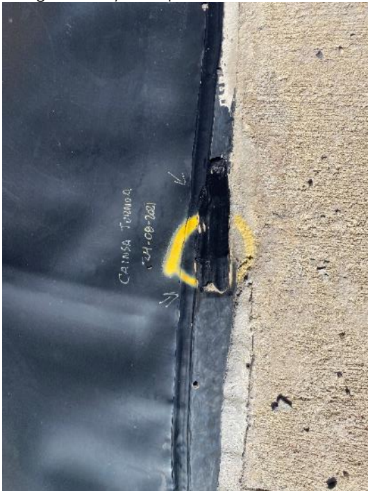
Fotografías 13 y 14: reparación de unión al inserto polimérico en rampa de acceso
