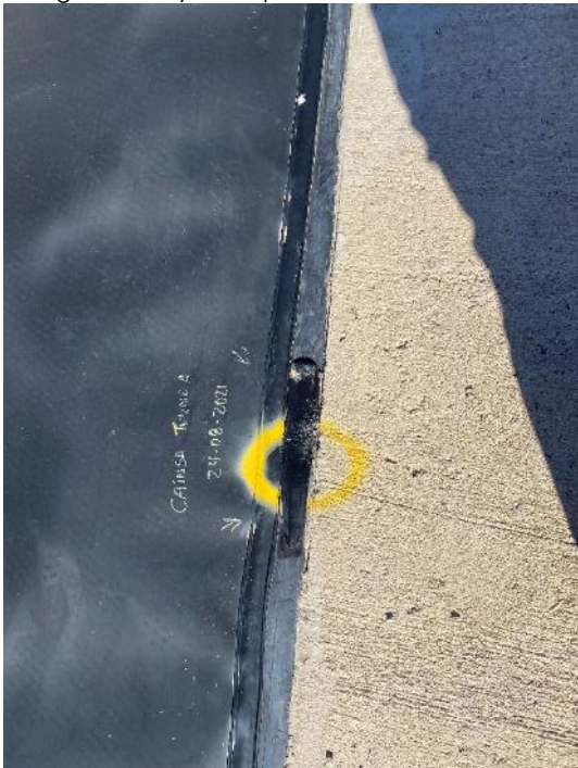
Fotografías 17 y 18: reparación de unión al inserto polimérico en rampa de acceso
