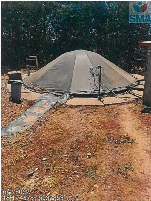
Foto N° 1. Estación N° 1 pozo de acumulación recría, se observa cobertura de afluente sobre unidad de acumulación.
