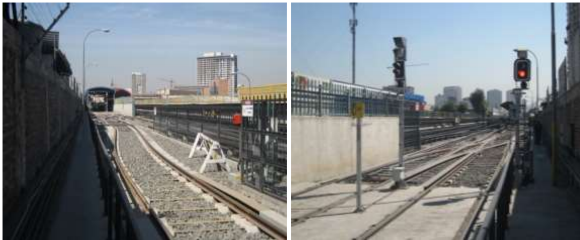
Figura 3. Zona aparcamiento maquinaria mantenimiento de vías.
