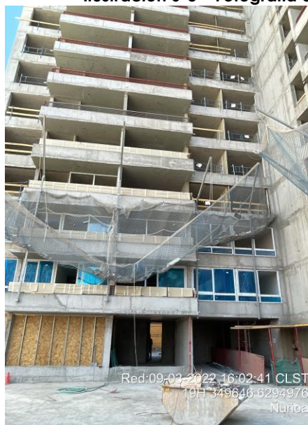
Faenas de terminación y desbaste de hormigón en pisos superiores
