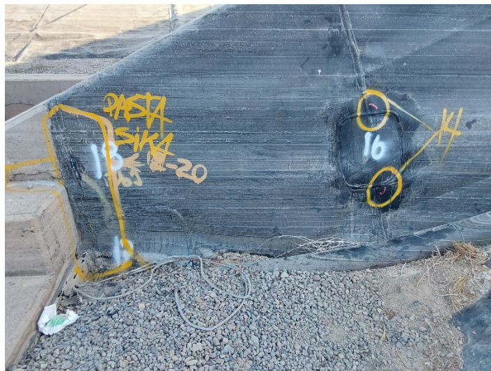
Fotografía 16: Reparación 16 con dos fallas (nueva 14) y 17-18 con observaciones
