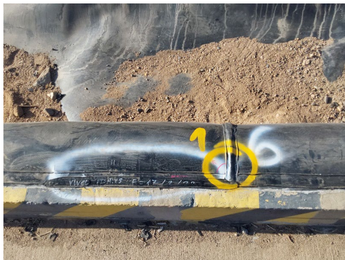
Fotografía 8: Reparación 6 aprobada, junto nueva falla 1
