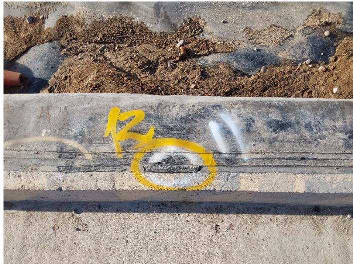
Fotografía 13: Reparación 11 falla, se marca como nueva falla 12
