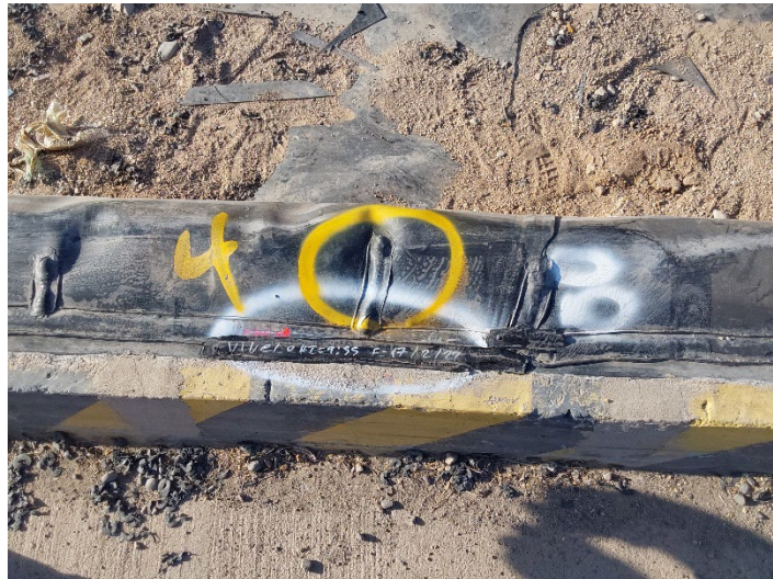
Fotografía 10: Reparación 8 aprobada, junto nueva falla 4
