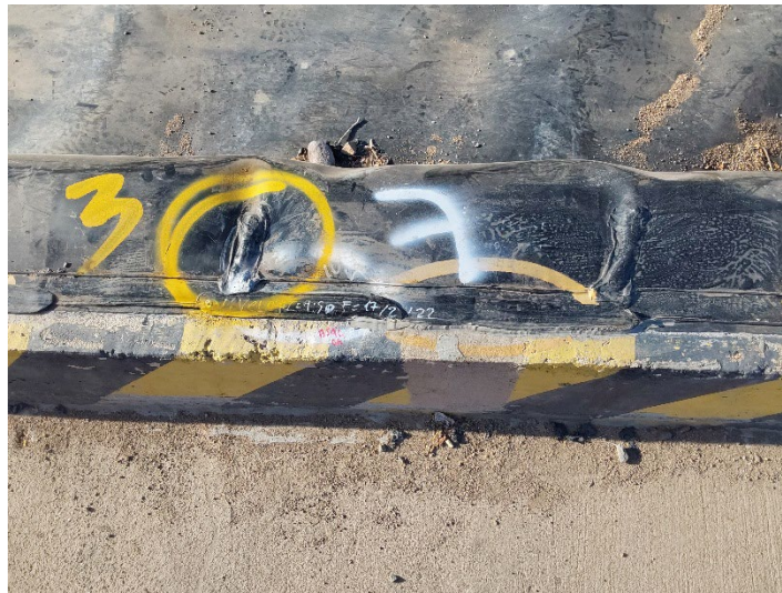
Fotografía 9: Reparación 7 aprobada, junto nueva falla 3
