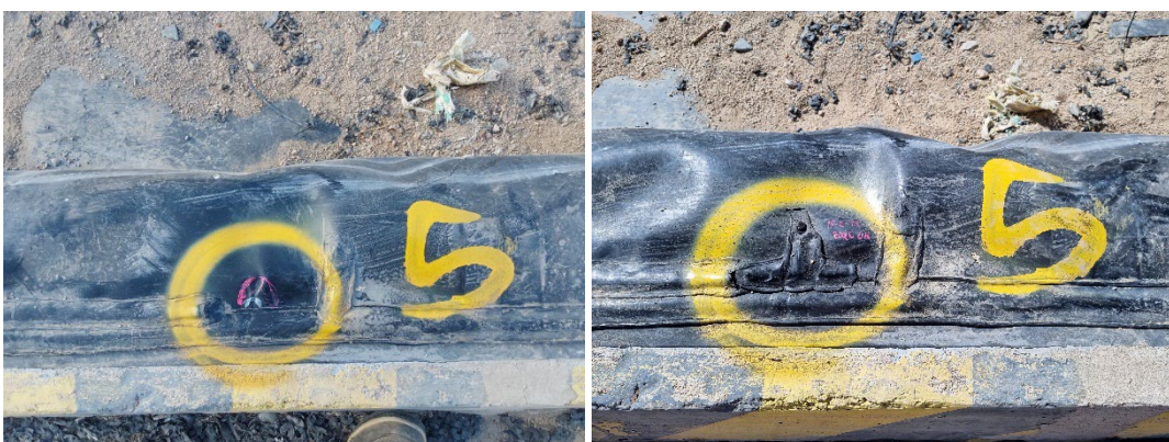
Fotografía 5: Reparación falla 4, antes y después
