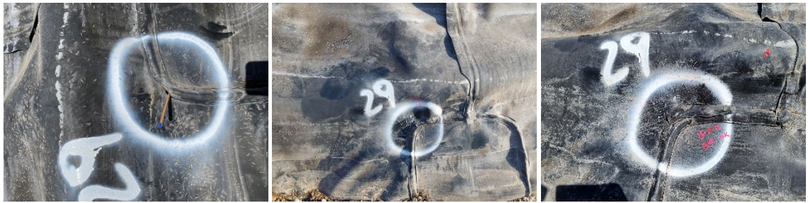
Fotografía 17: falla 29, reparación falla 29 y refuerzo de falla 29 informe INF-INS-2022-015
