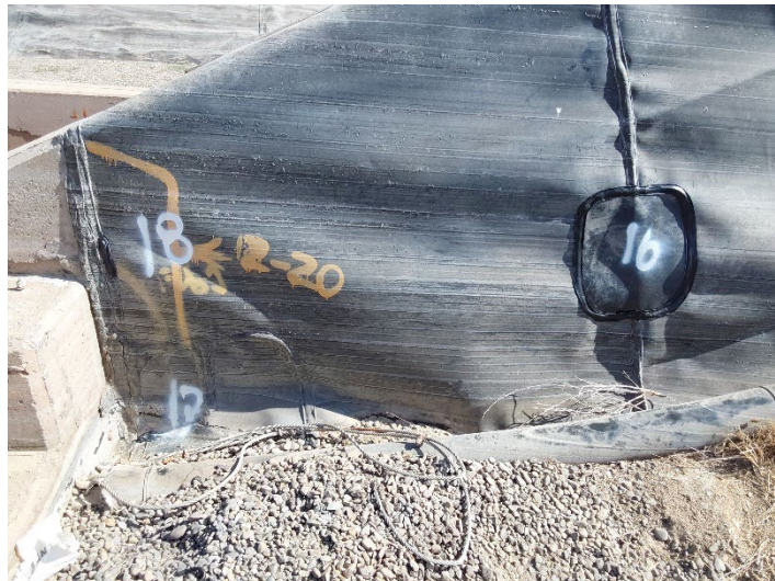
Fotografía 14: fallas 16, 17 rotura geomembrana y falla 18 (mala reparación)
