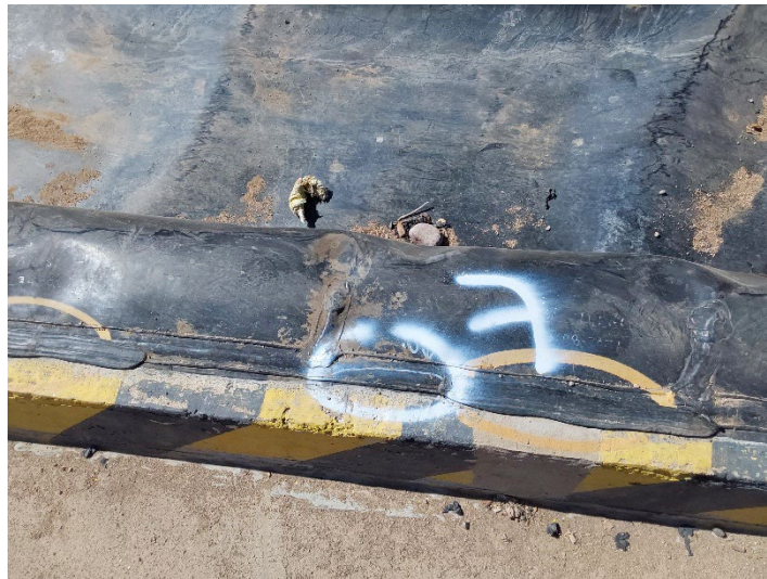
Fotografía 7: falla 7 rotura de inserto (antigua 10)
