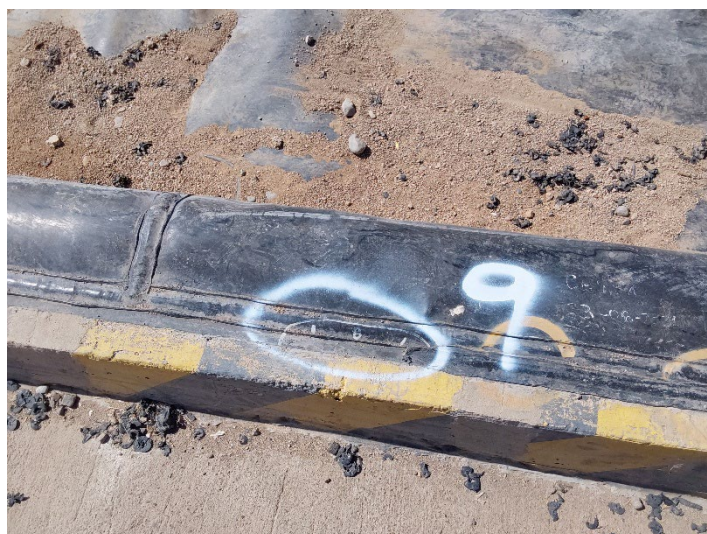
Fotografía 9: falla 9 rotura de inserto (antigua 6)
