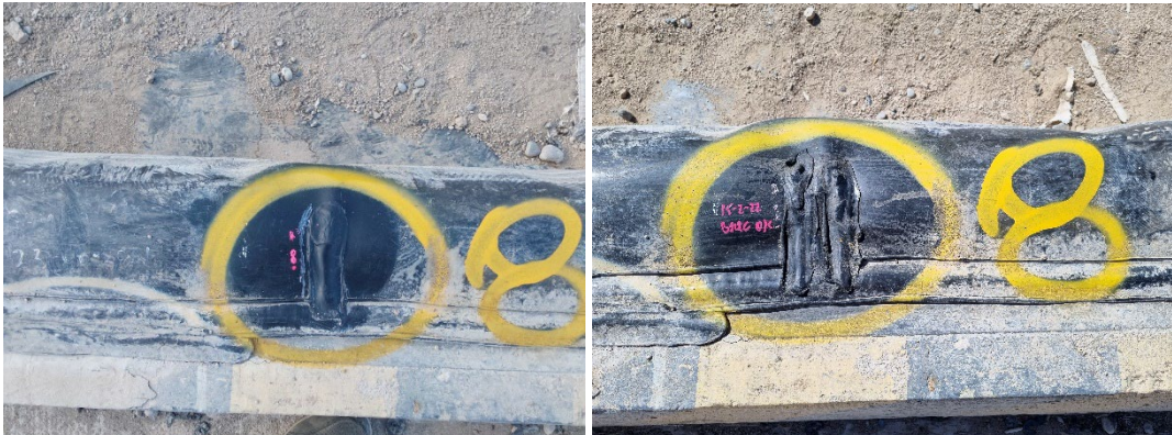
Fotografía 9: Reparación falla 8, antes y después
