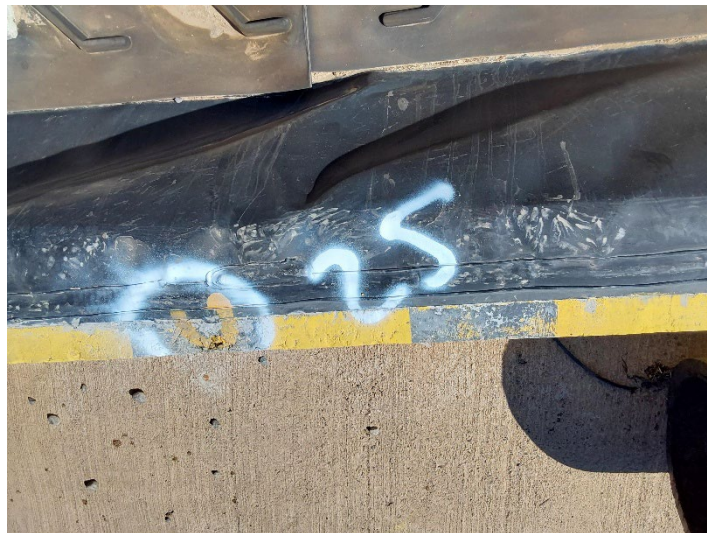
Fotografía 20: falla 25 filtración de extrusión en inserto
