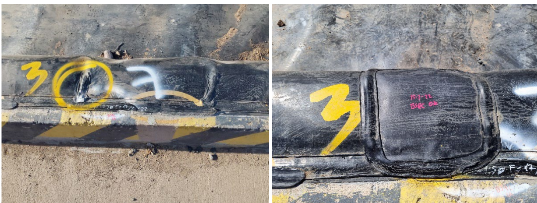
Fotografía 4: Reparación falla 3, antes y después
