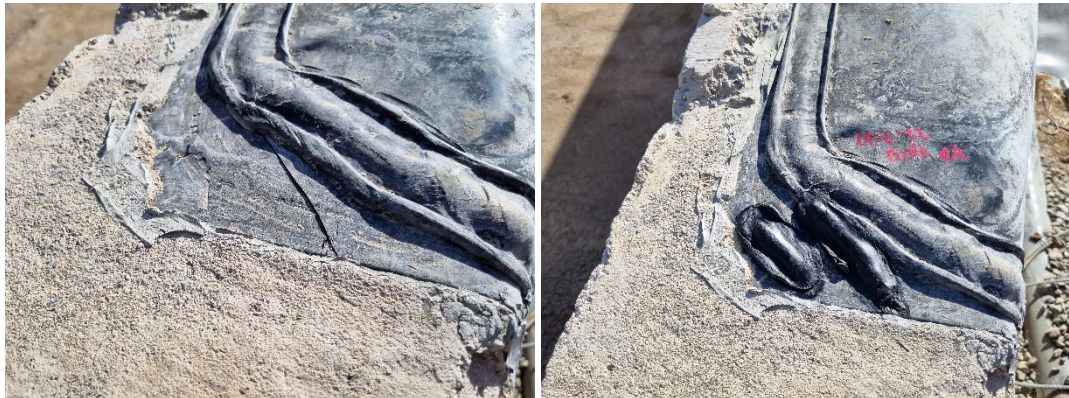
Fotografías 19: reparación inserto hombro de pared de cajón
