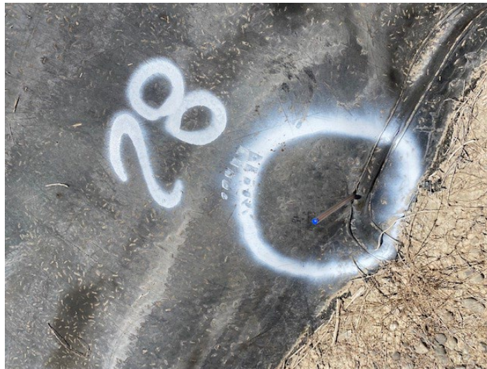
Fotografía 22: falla 28 rotura de geomembrana en perímetro de parche
