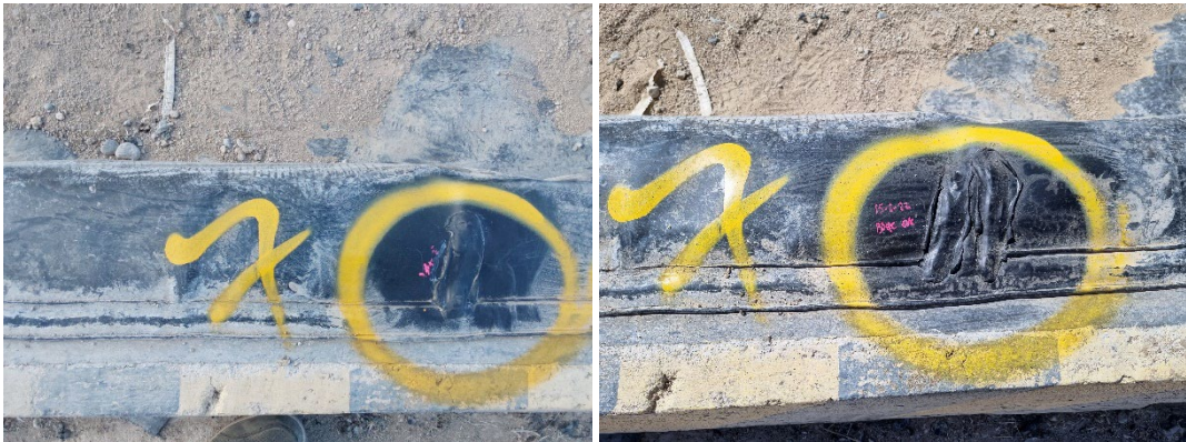
Fotografía 8: Reparación falla 7, antes y después
