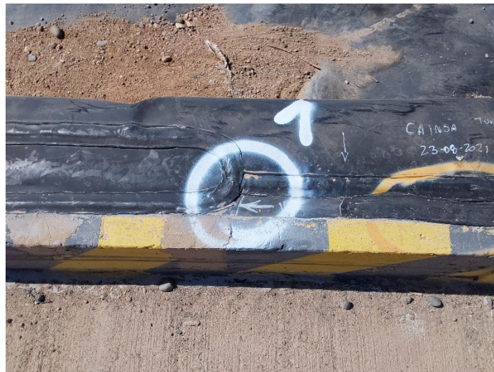
Fotografía 2: falla 1 rotura de inserto
