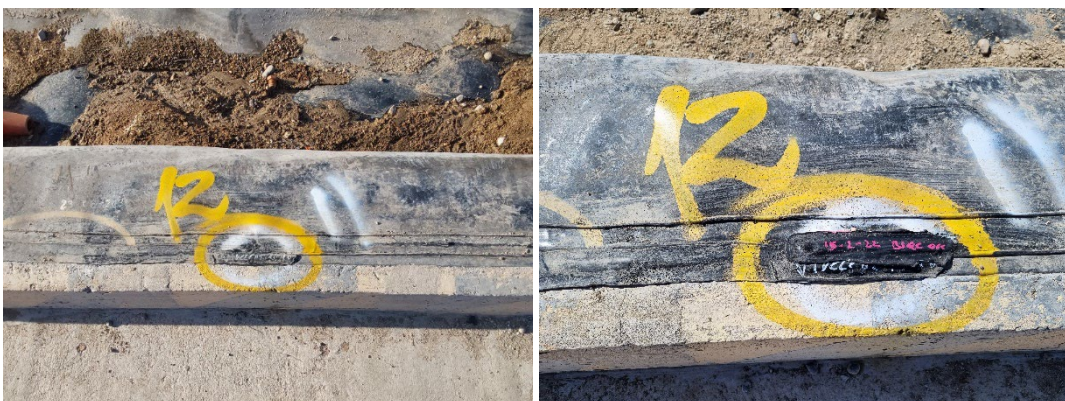
Fotografía 12: Reparación falla 11, antes y después
