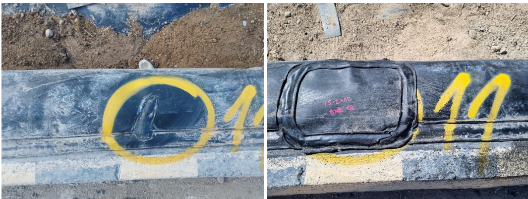
Fotografía 12: Reparación falla 11, antes y después
