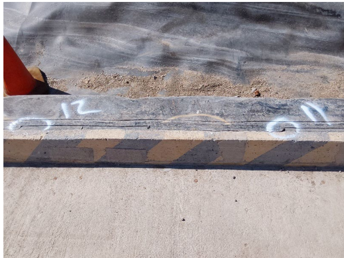
Fotografía 11: fallas 11 y 12 rotura de inserto (mala reparación)
