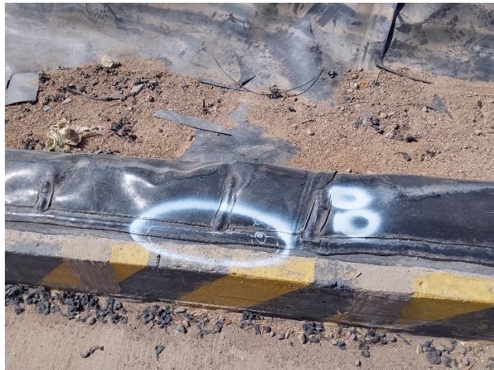
Fotografía 8: falla 8 rotura de inserto (antigua 9)
