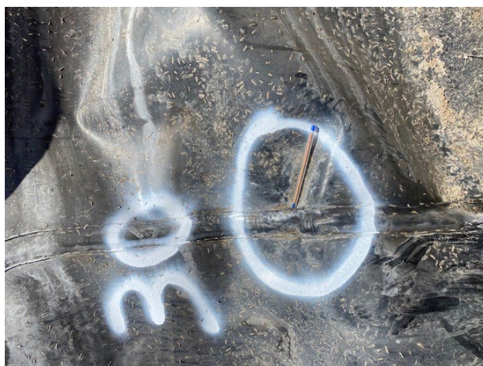
Fotografía 24: falla 26 filtración de parche
