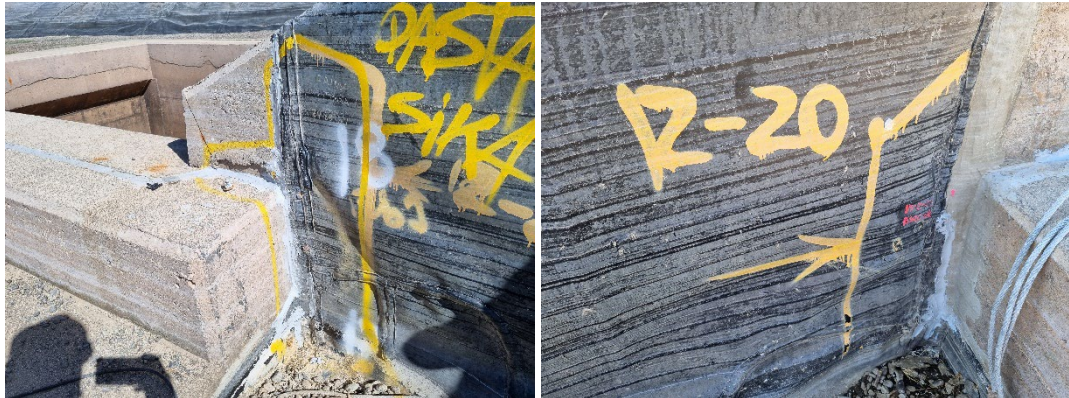
Fotografías 18: reparación esquina hormigón lado sur izquierda, lado norte derecha
