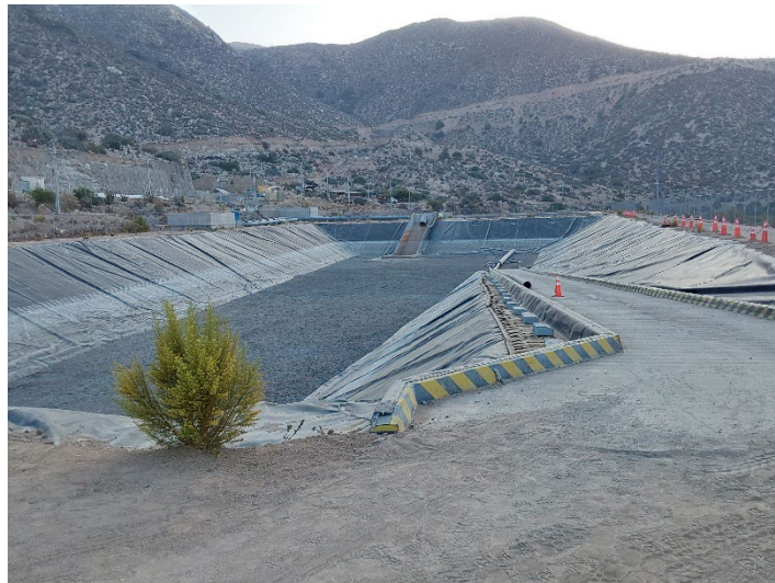
Fotografía 1: Vista general de piscina de emergencia relaveducto Tk10 de estación Camisas.
