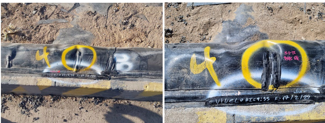
Fotografía 5: Reparación falla 4, antes y después
