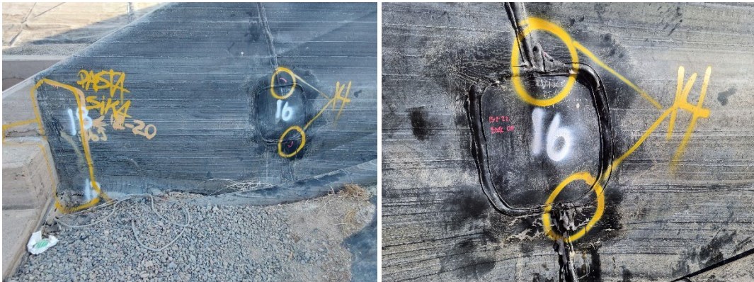
Fotografía 15: Reparación falla 14, antes y después
