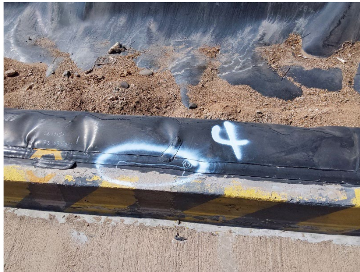
Fotografía 4: falla 4 rotura de inserto (antigua 13)
