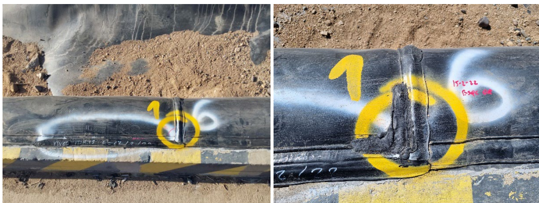
Fotografía 2: Reparación falla 1, antes y después
