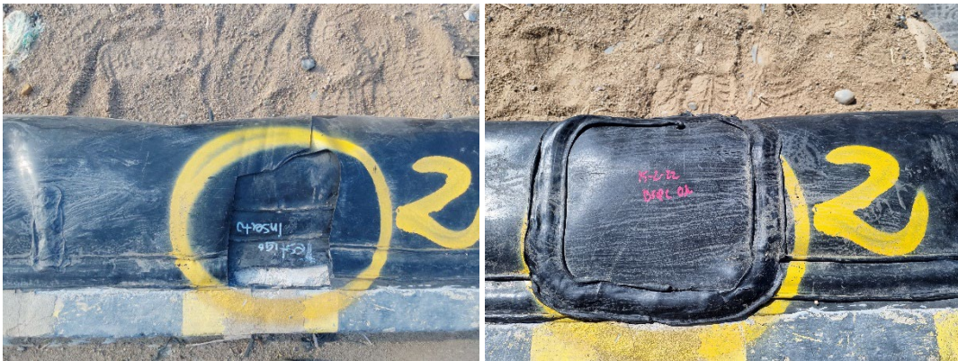
Fotografía 3: Reparación falla 2, antes (se toma muestra) y después reparación
