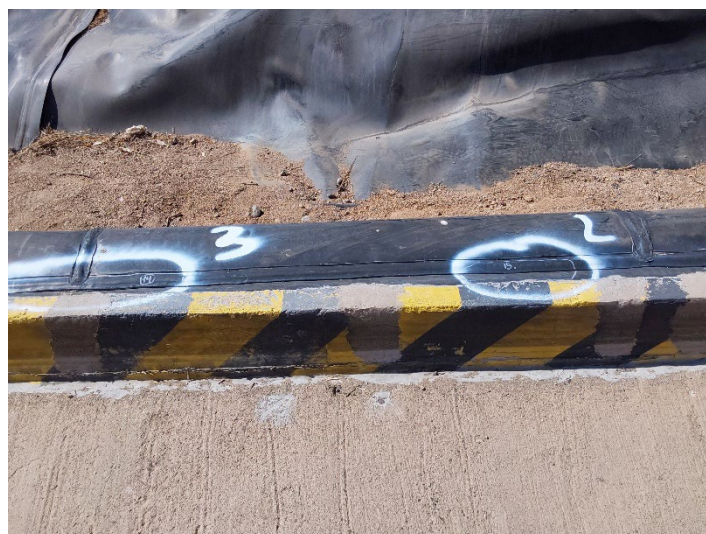
Fotografía 3: fallas 2 y 3 roturas de inserto (antiguas 14 y 15)
