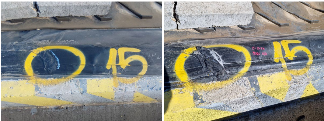
Fotografía 16: Reparación falla 15, antes y después
