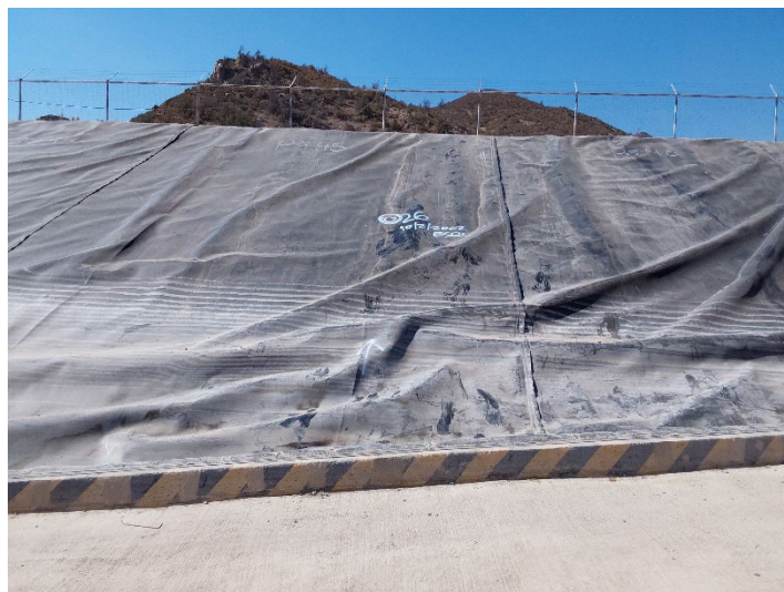
Fotografía 21: falla 26 rotura de geomembrana por impacto
