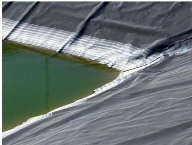
Evidencia visual de máximo nivel almacenado (manchas blancas)
