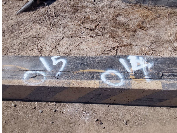
Fotografía 13: fallas 14 y 15 rotura de inserto (mala reparación)
