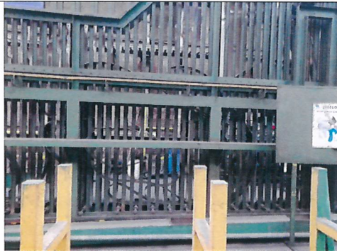
Fotografía 1. Equipo procesamiento de acero
