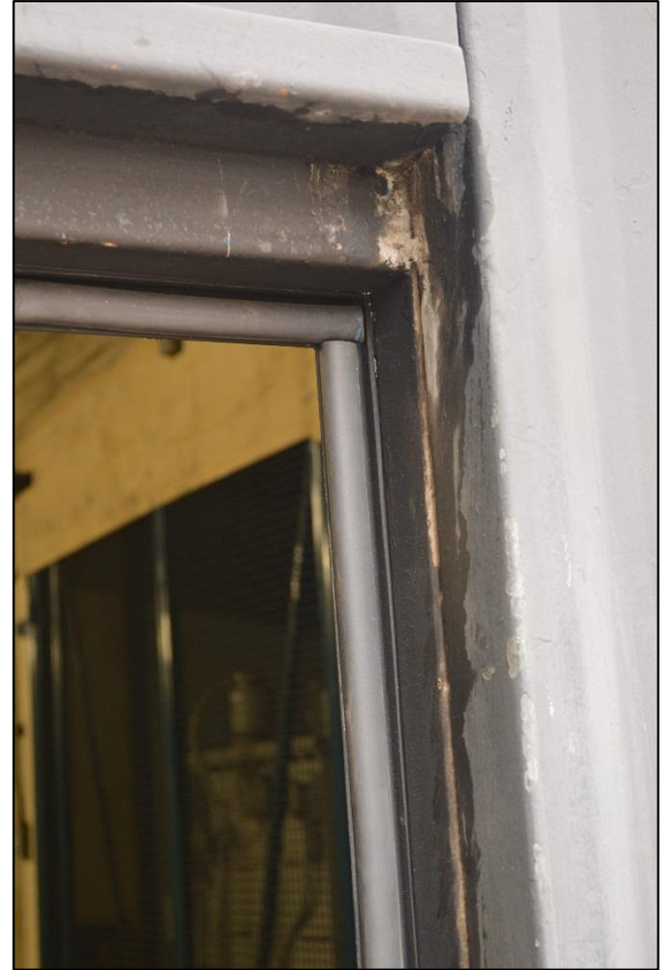
Imagen 13 – Sellos perimetrales instalados en portones de acceso.
