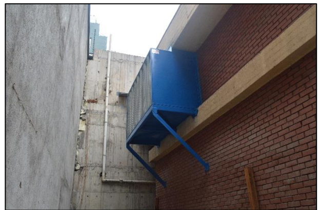
Imagen 12 – Soluciones de control de ruido instaladas en vanos de admisión y descarga.
