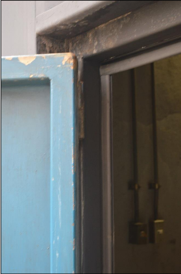
Imagen 13 – Sellos perimetrales instalados en portones de acceso.
