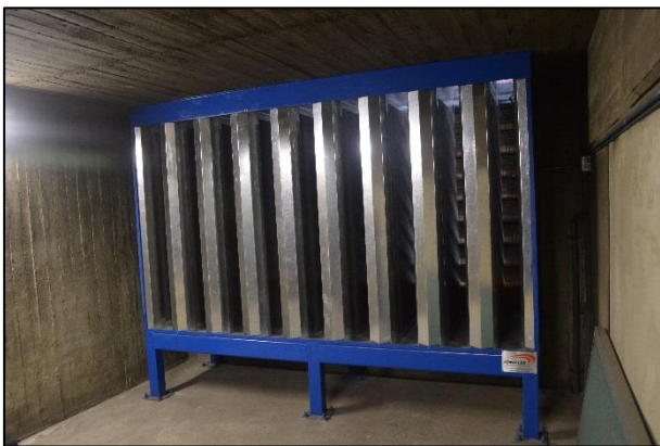
Imagen 12 – Soluciones de control de ruido instaladas en vanos de admisión y descarga.
