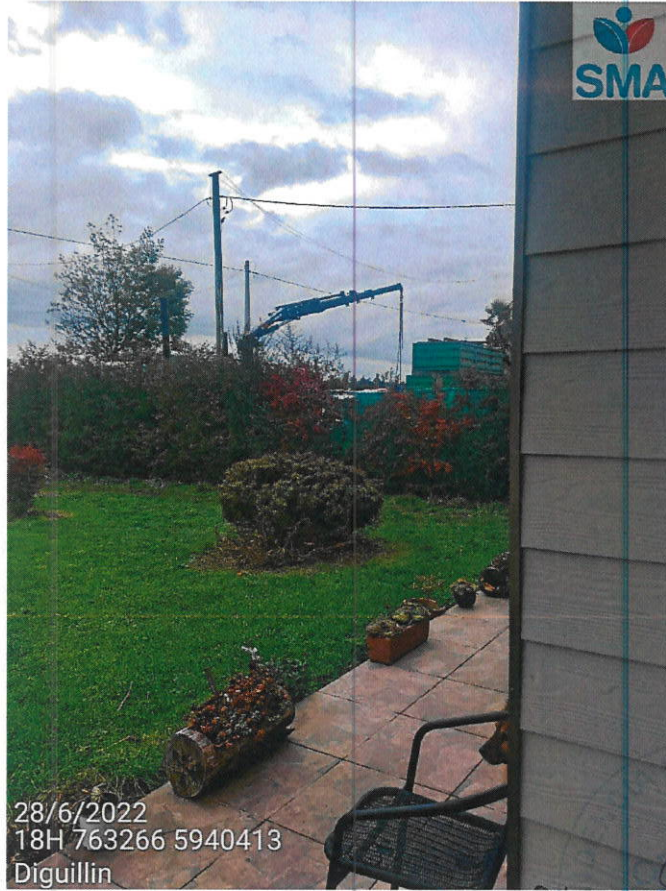
Foto 5. Vista desde casa denunciante de actividades de grúa pluma
