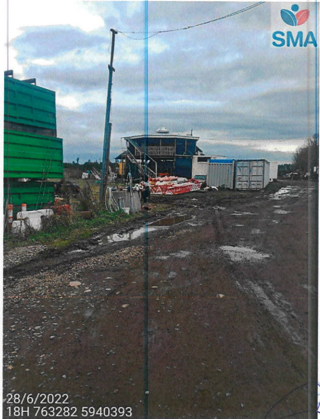
Foto 4 . Vista parcela N6 de otra zona donde tambien existe esructuras semejantes ha cia interior de propiedad.
