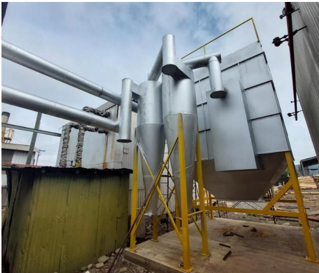
Filtro de mangas instalado en caldera SSMAU-350
