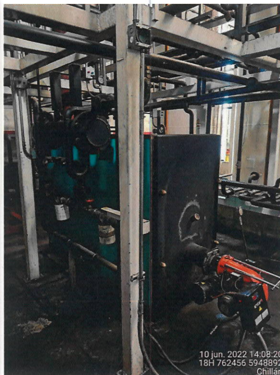
Foto 1 Quemador y Caldera de fluido de aceite industrial
