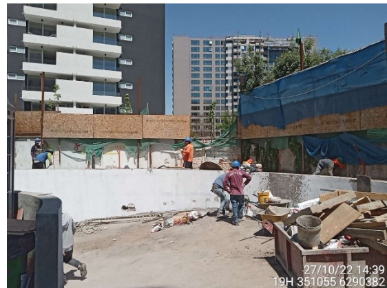
Trabajos al interior de Unidad Inspeccionada
