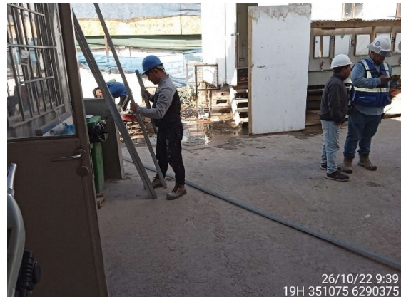
Golpes de material
