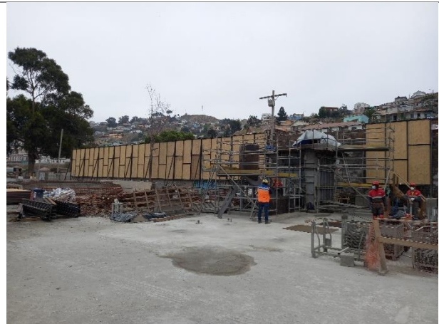
Barrera Acústica Patio Fabricación de Pilotes Norte – 5.5 m de altura
