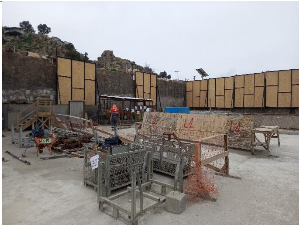
Barrera Acústica Patio Fabricación de Pilotes Norte – 5.5 m de altura
