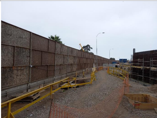
Barrera Acústica Patio de Prefabricados – 5.5 m de altura
