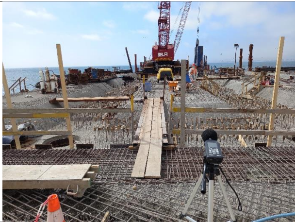
Hincado de Pilotes Vertical (se aprecia uso de Barrera de 10 m de altura tipo encamisado al martinete)
