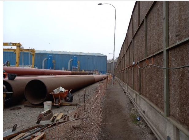
Barrera Acústica Patio de Prefabricados – 5.5 m de altura
