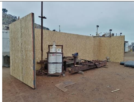
Barreras modulares a procesos específicos
