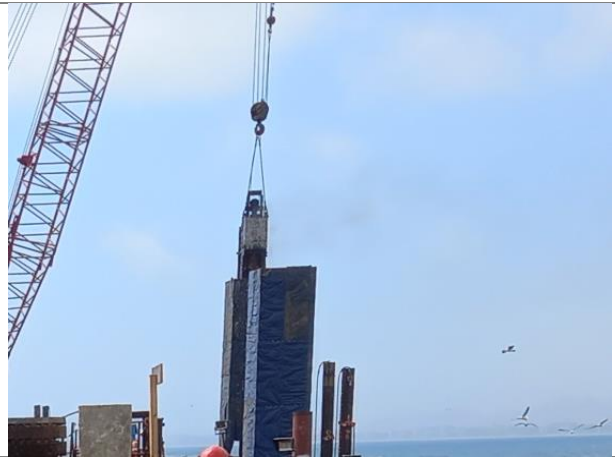
Hincado de Pilotes Vertical (se aprecia uso de Barrera de 10 m de altura tipo encamisado al martinete)
