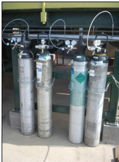
**Fotografía 2:** Cilindros de gases patrones a la intemperie
