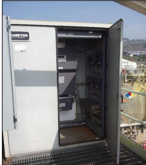
**Fotografía 1:** Analizador SO<sub>2</sub> con puerta de protección abierta
