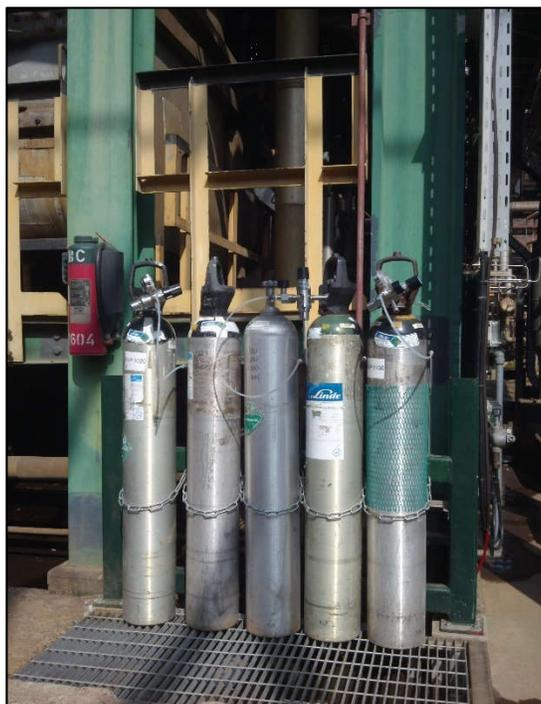
**Fotografía 3:** Cilindros de gases patrones a la intemperie
