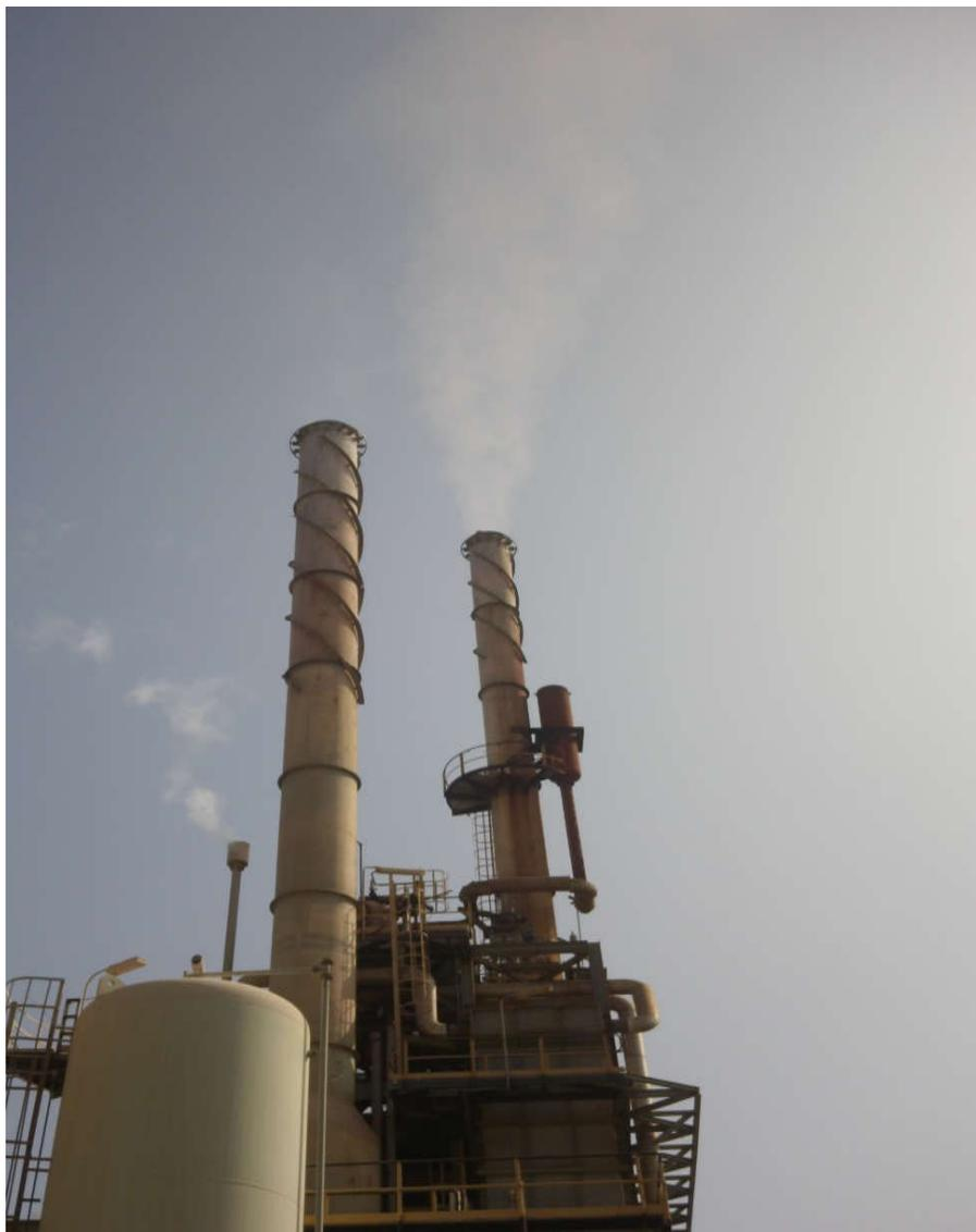
**Fotografía 4:** Vista 1 Cracking Catalítico, con su chimenea principal (derecha) y chimenea Bypass (ambas emitiendo).
