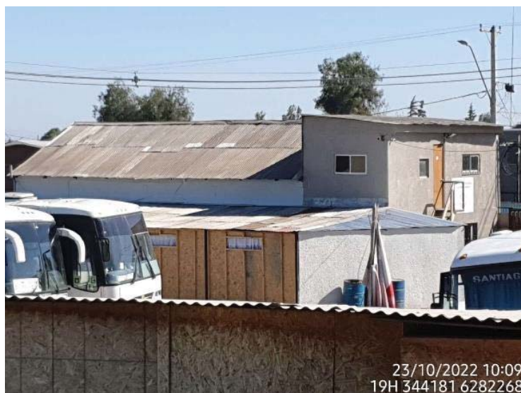
Vista Unidad Inspeccionada desde vivienda denunciante
