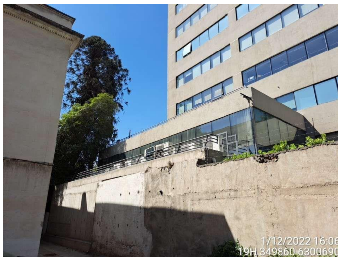
Equipos de clima
