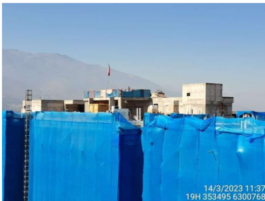
Trabajos en cubierta
