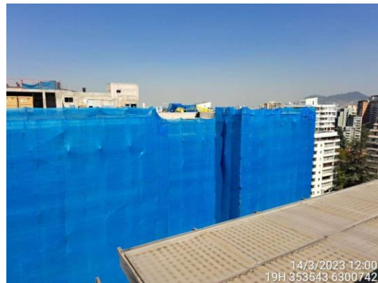
Vista general fachada oriente
