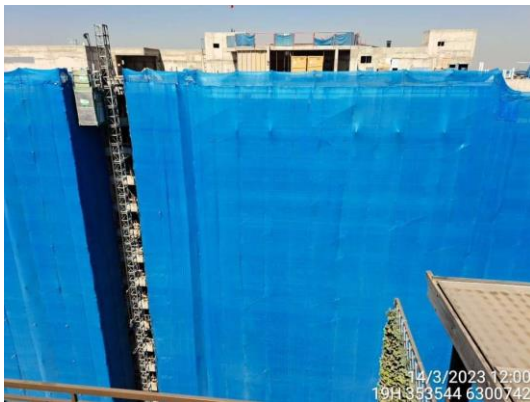
Fuentes de ruido al interior de obra gruesa
