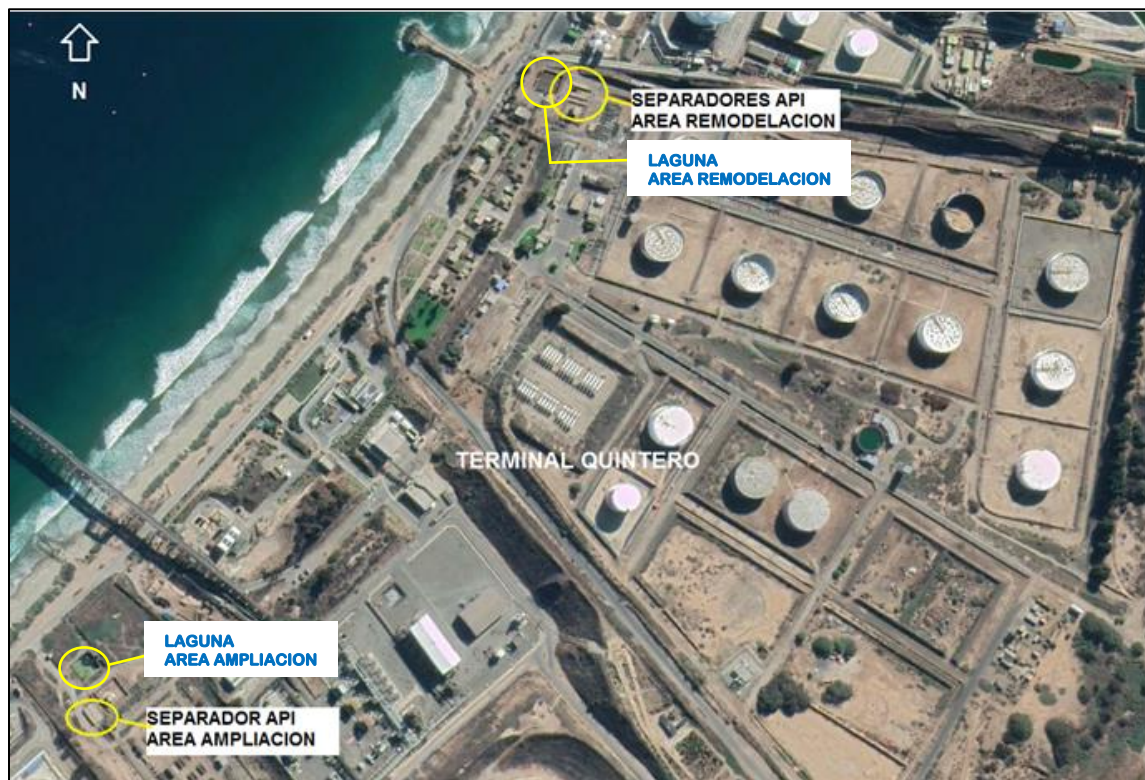
Figura 1: Vista General Terminal Quintero, ubicación lagunas y separadores.
