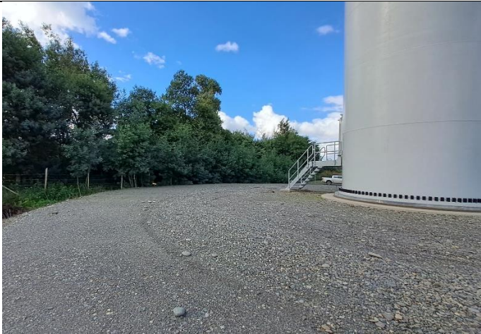
Fotografía 13. Alrededor del aerogenerador N°12.
