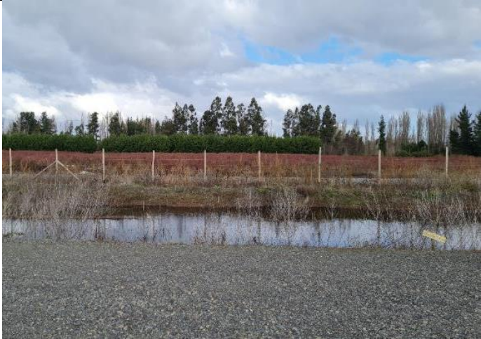
Fotografía 21. Afloramiento de agua alrededor del aerogenerador N°8.
