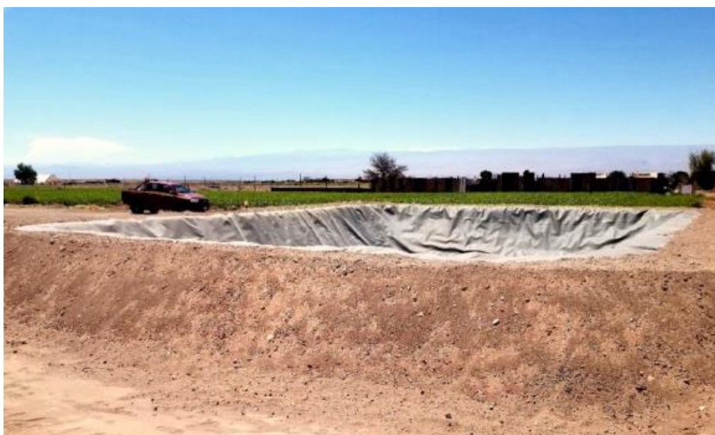
Imagen 1. Construcción de estanque de acumulación de agua.
