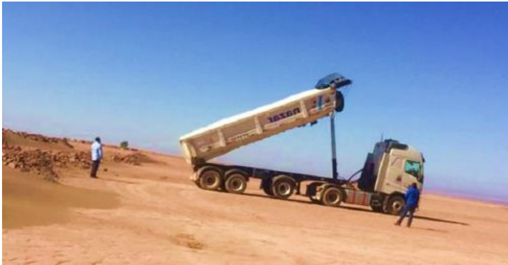
Imagen 6. Aplicación de Bischofita para mejoramiento de caminos internos.
