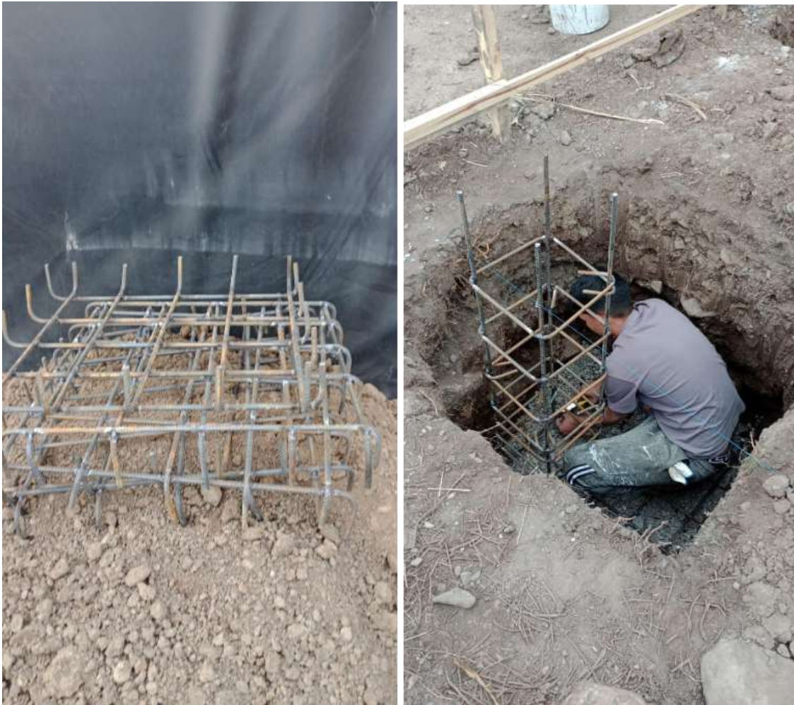
Preparación de enfierradura destinada a las fundaciones
