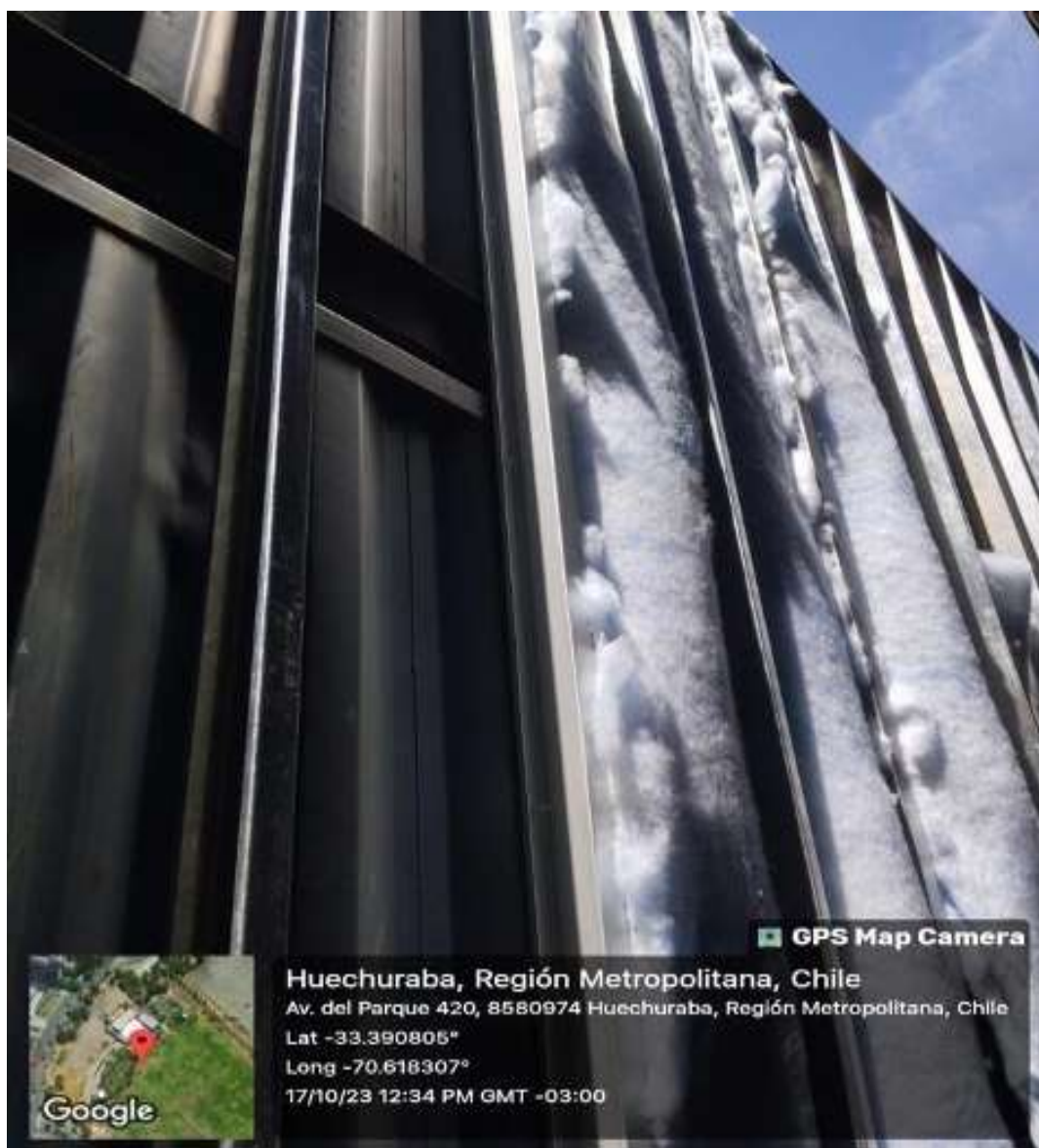
Detalle de espuma acústica aislante entre costaneras de metalcom
