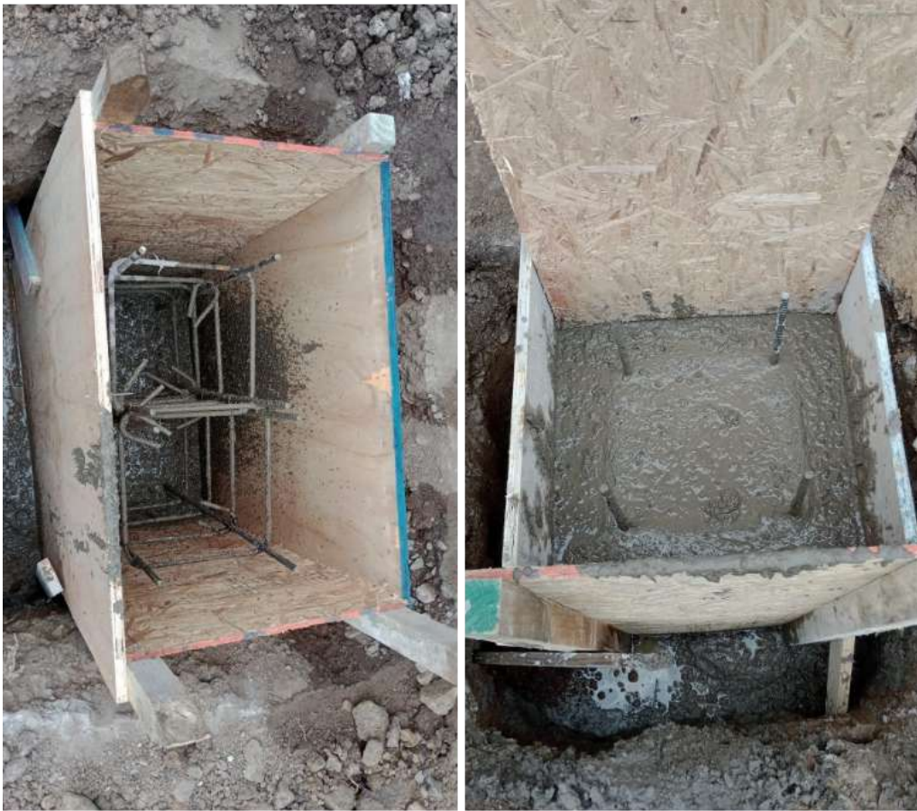
Encofrado listo para recibir hormigón
