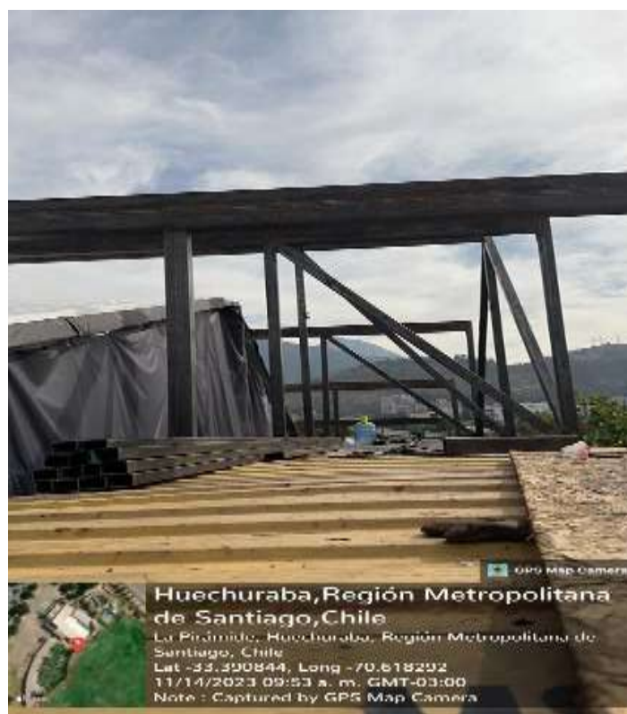
Vista superior de los contenedores y construcción de techumbre de dos aguas en voladizo
