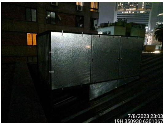
Equipo central de aire con silenciador
