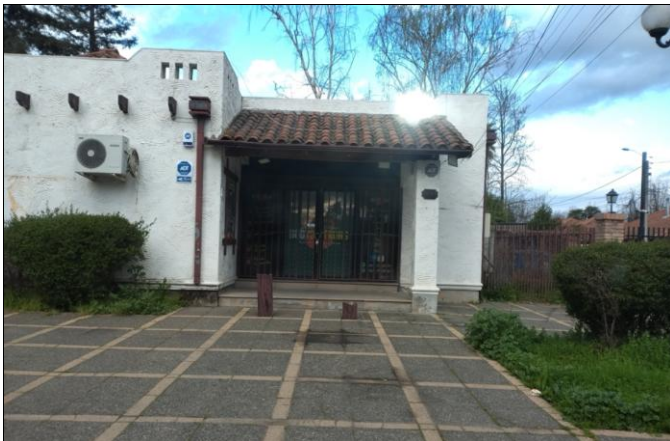
Fotografía 1. Vista general de la unidad fiscalizable.
