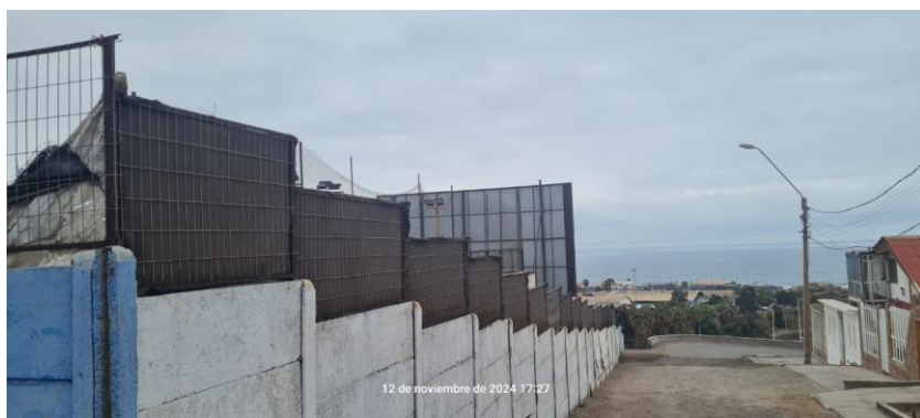
Exterior calle Santa Marte
