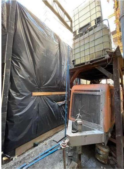
d) Departamentos con trabajos de terminación se dispone de paneles de aislamiento acústicos en vanos, elaborados con marcos de madera, rellenos de plumavit, lana mineral y forradas con mallas Rachel.
