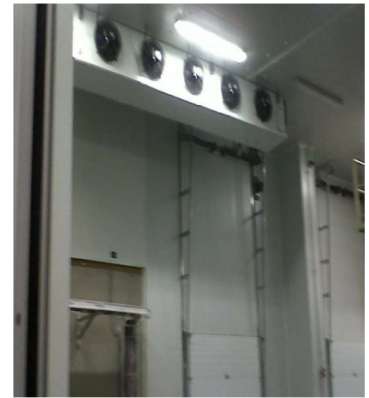
Evaporadores de refrigeración (Interior)
