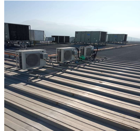
Equipos de climatización (Roof-Top y Split UE)
