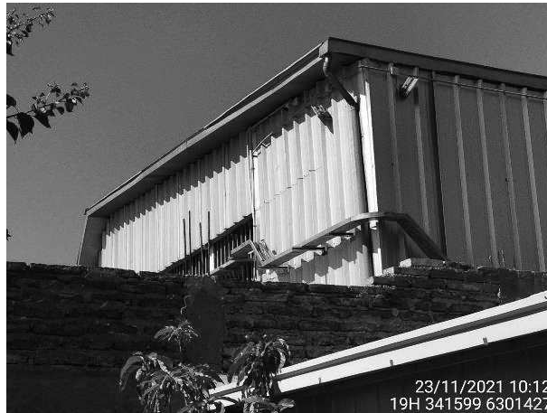
Vista Unidad Inspeccionada desde receptor
