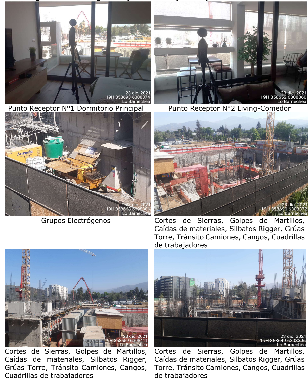
Figura N° 2 Fotografías puntos receptores y fuentes de ruido
