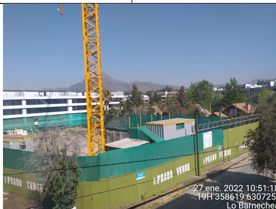
Obra de construcción de un edificio
