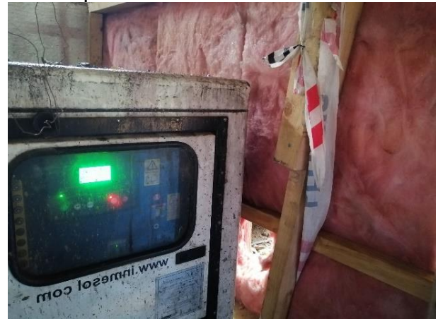
Encierro acústico Generador piso 1
