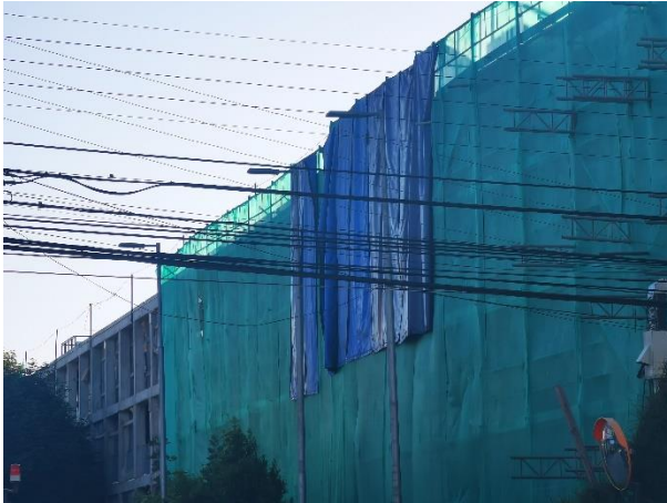
Ilustración 6-1 Fotografías de las medidas de control implementadas Vista de Barrera Vinilica de alta densidad hacia centro comercial, Botellas Licorería, Av Ramon Picarte 1524.
