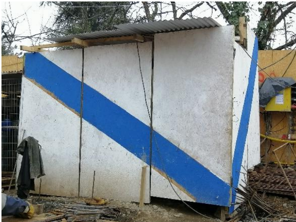
Encierro acústico Generador piso 1
