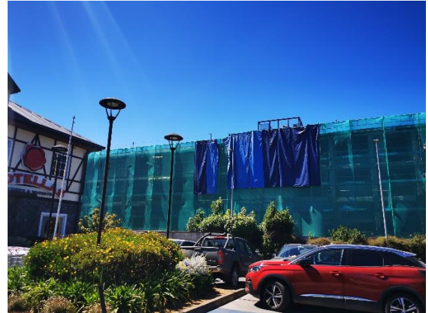
Ilustración 6-1 Fotografías de las medidas de control implementadas Vista de Barrera Vinilica de alta densidad hacia centro comercial, Botellas Licorería, Av Ramon Picarte 1524.
