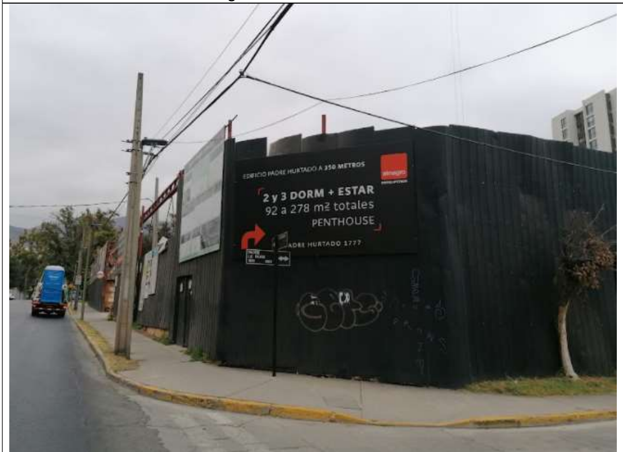
Fotografía 2: Cierro de Obra Exterior
