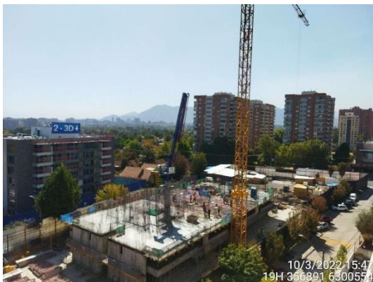
Vista general de la obra
