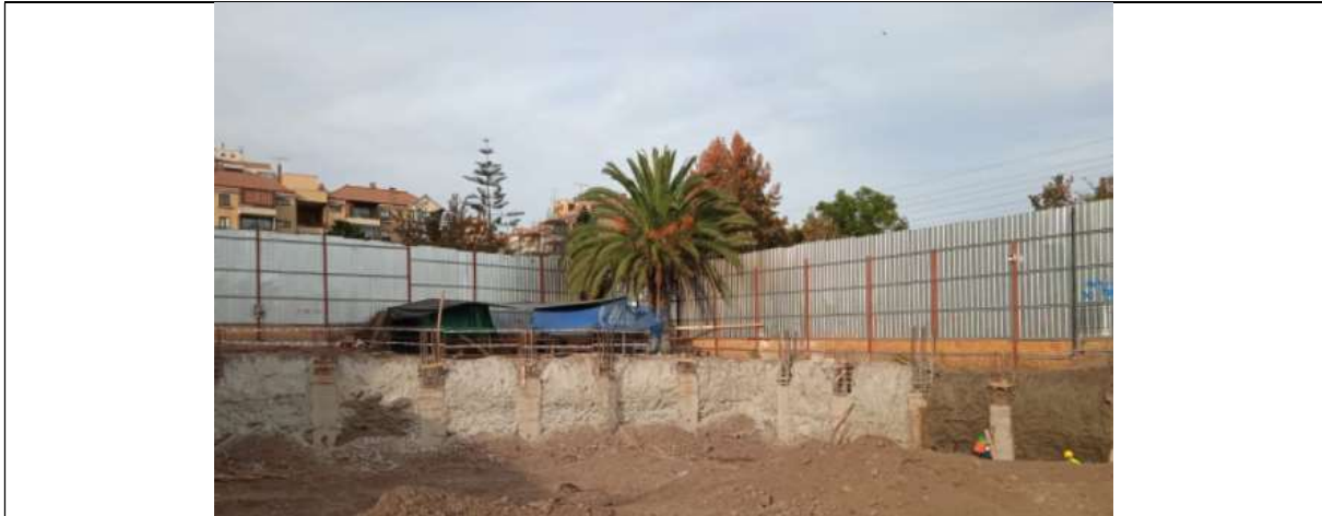
Fotografía 1: Cierro de Obra Interior
