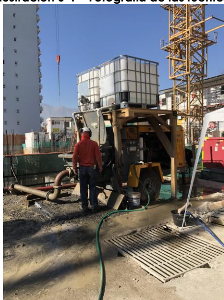
Bomba de hormigón
