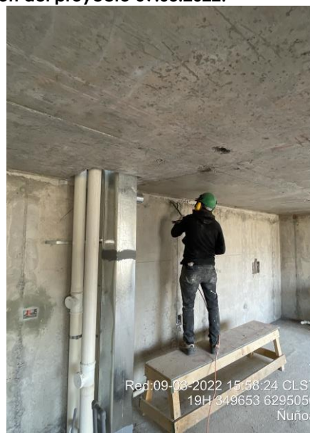
Desbaste de hormigón
