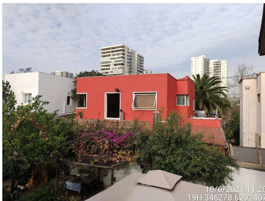
Equipos de refrigeración
