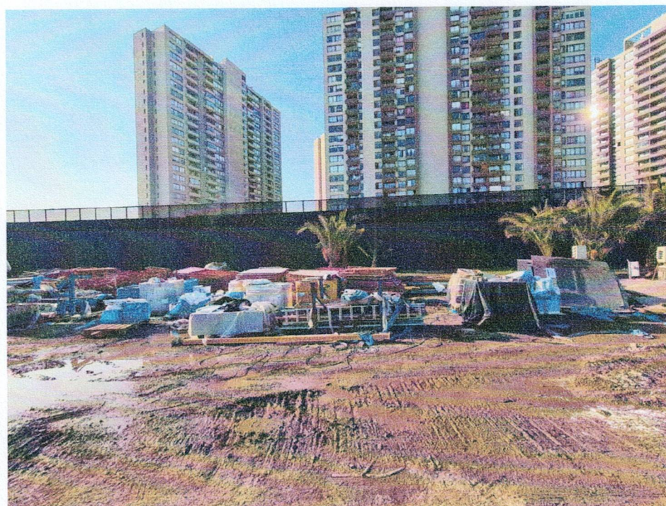
Foto 2: Construcción del cierre perimetral norte
