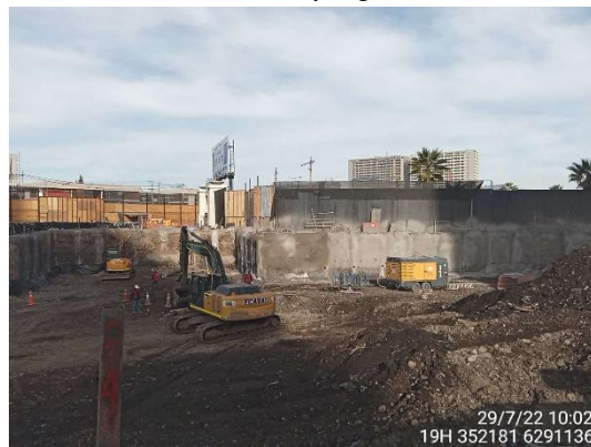
Retroexcavadora y compresor
