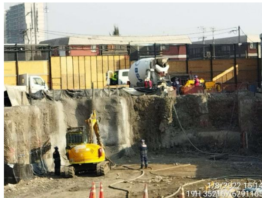
Shotcrete y camión mixer
