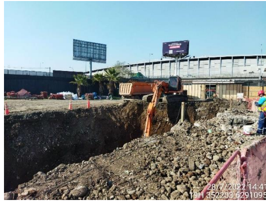
Retroexcavadora y carga de tolva
