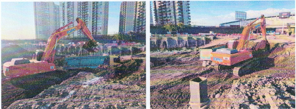
Foto1: excavadora en obra el 28/07/22
