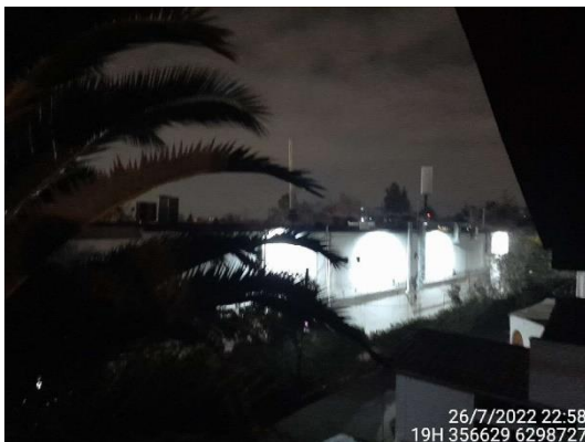
Vista general de cubierta
