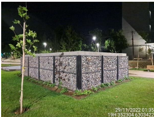
Sala de máquina
