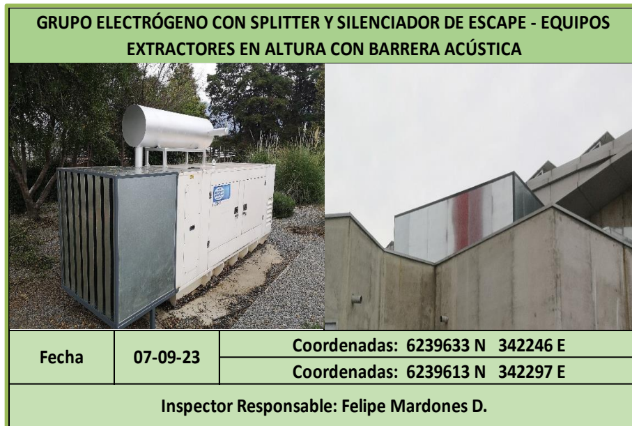
Figura 1-b): Grupo electrógeno con splitter y silenciador de escape implementado más equipos extractores en altura con barrera acústica implementada
