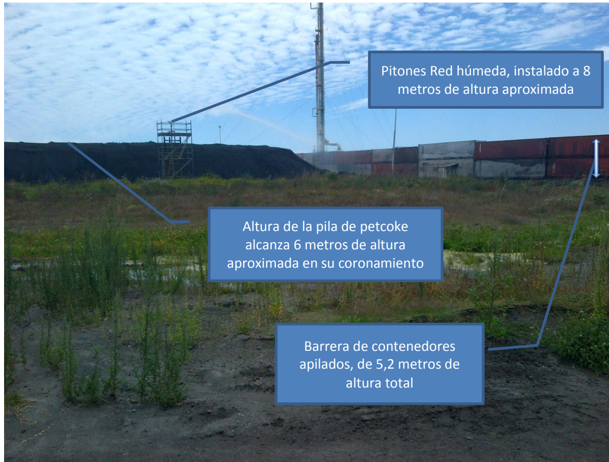
Fotografía N° (de fecha 31-01-2013)
