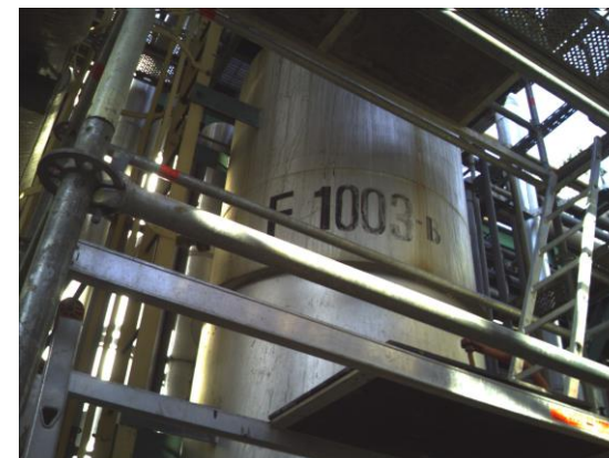
Fotografía N° (de fecha 31-01-2013)
