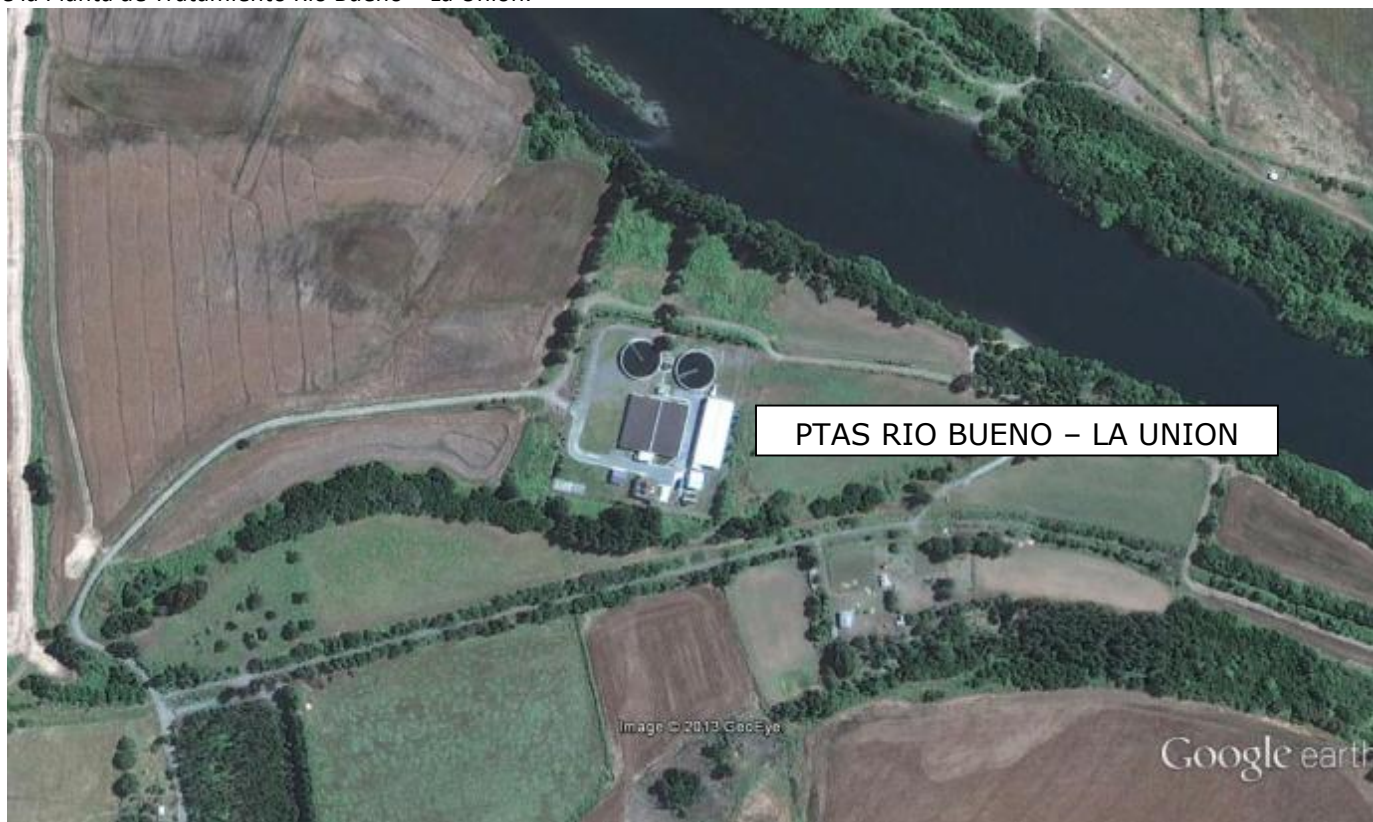
Figura N° 4: Vista de la Planta de Tratamiento Río Bueno – La Unión.
