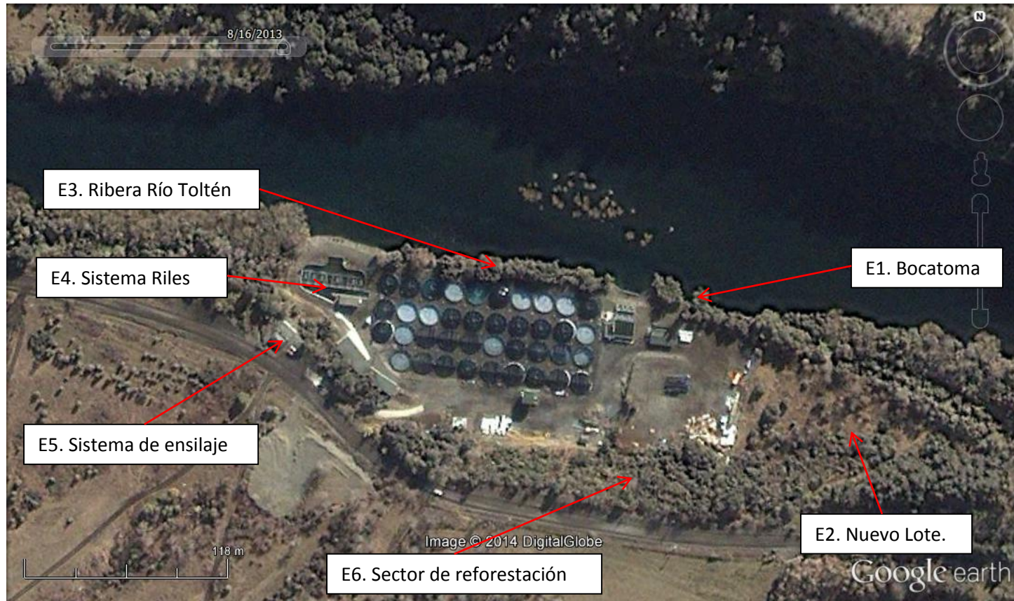
Figura 4. Recorrido realizado durante la inspección ambiental (Fuente: Google Earth 2013).
